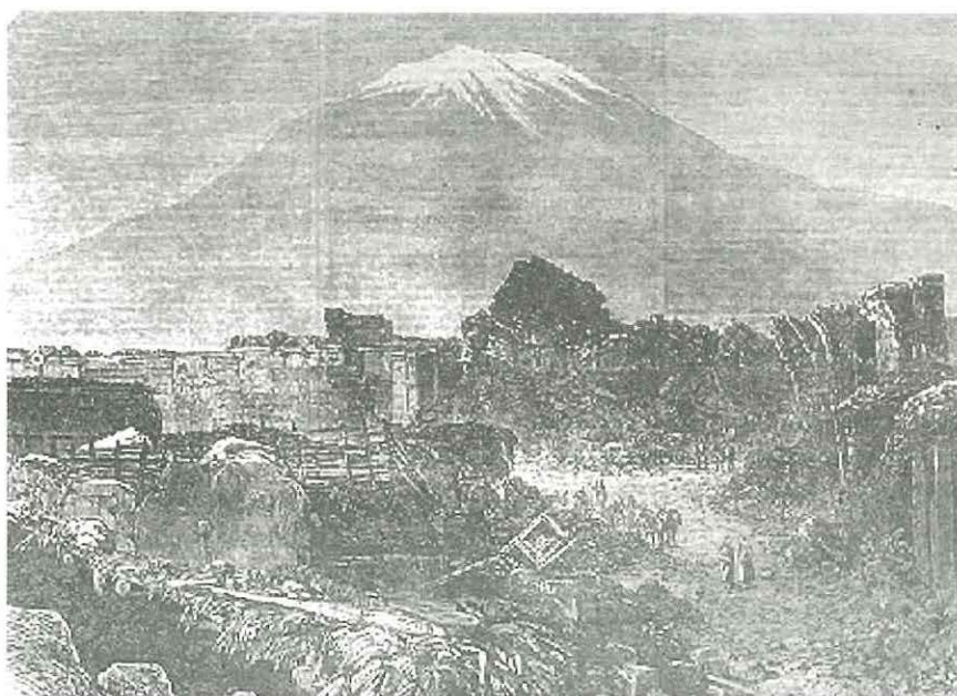
Figura 2. Terremoto de 1868. Templo de San Antonio, Arequipa, en ruinas
