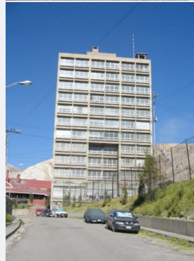
Fig. 5 Zona de viviendas de empleados. Foto Archivo CIAC
