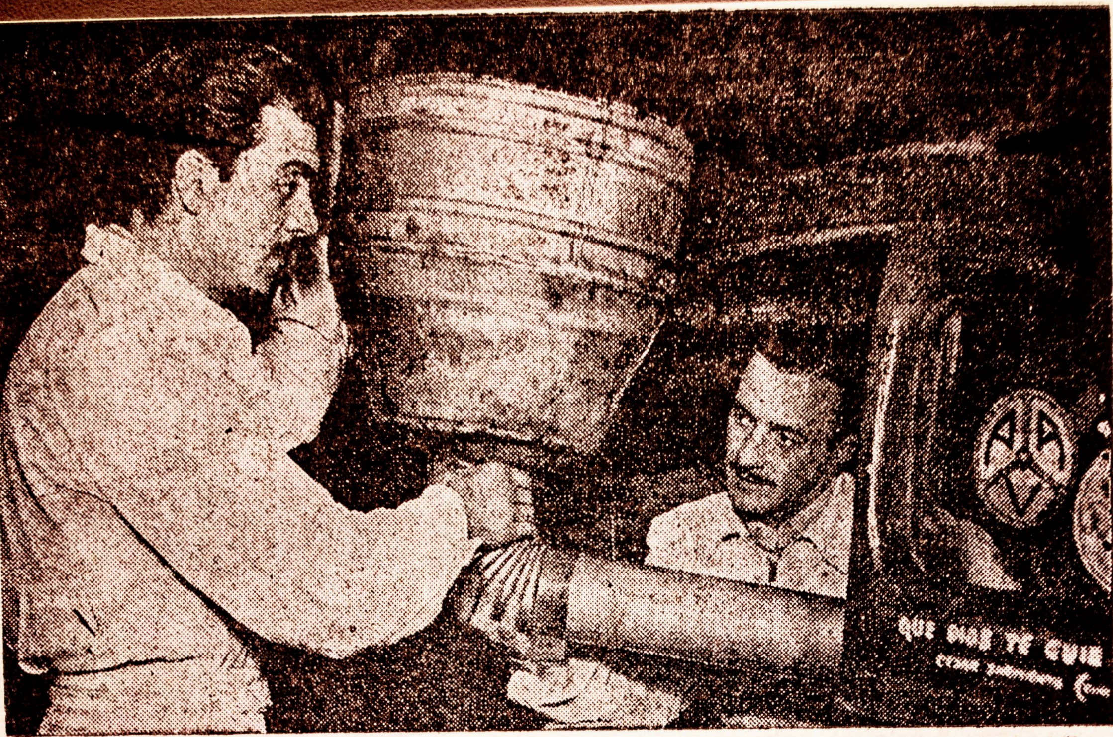
Este es el embudo que emplea Juan Gálvez para reaprovisionarse de gasolina en un minuto y tracción. Sus dimensiones permiten esa rapidez que se traduce en segundos ganados y ventaja que otorgan triunfos.
