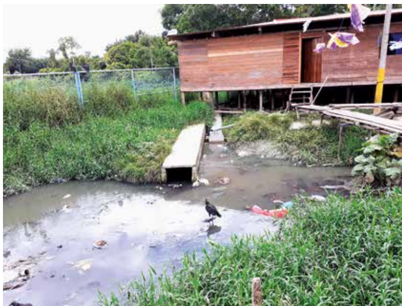
Figura 18. Tubería del Hospital EsSalud con salida al canal*
