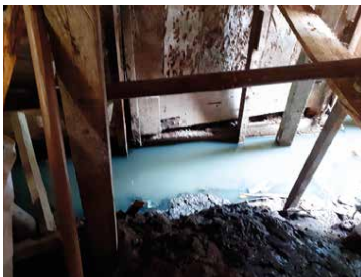
Figura 34. Parte baja de una vivienda
