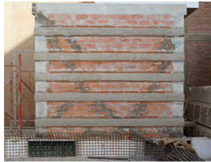
(d) Retrofitted wall
