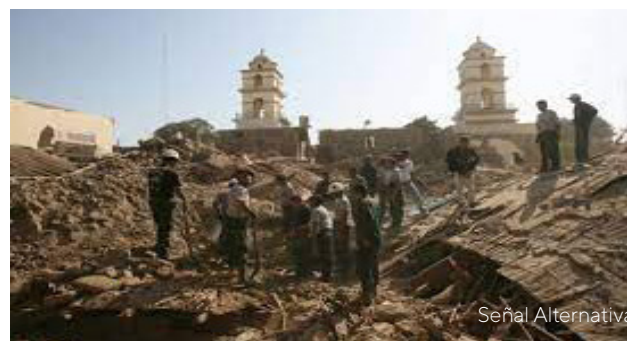
Terremoto de Pisco (2007)
