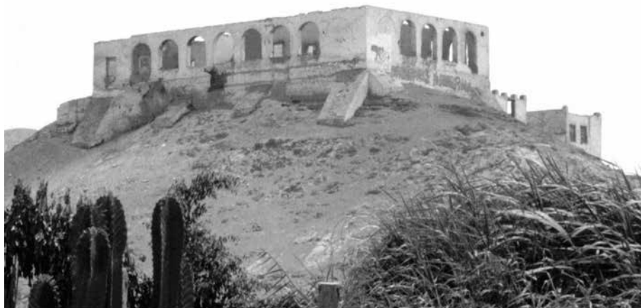
Figura 4. Vista general de la ex casa-hacienda.
