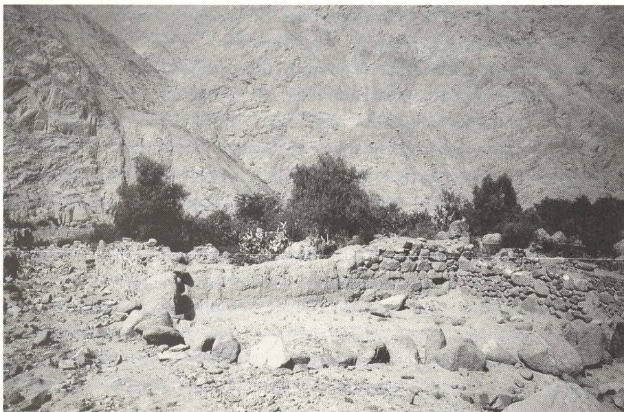
FIGURA 24. Estructura con adobes en Nieve Nieve.
