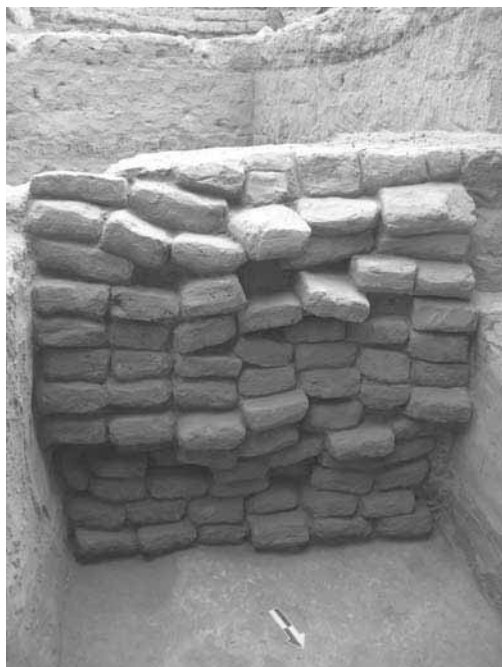
Figura 2. Sello visto desde el pozo de acceso.
