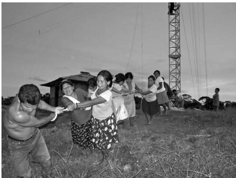
Figura 2. Jornada comunitaria para el izamiento de una torre de telecomunicaciones, en Rumi Tuni, ribera del río Napo, Loreto, mayo de 2005
