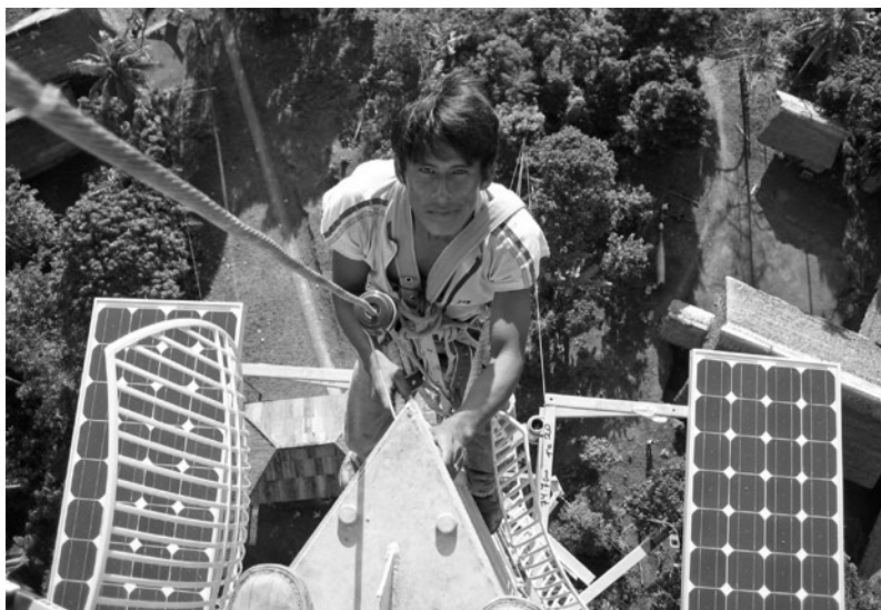
Figuras 1. Instalación de paneles fotovoltaicos y antenas IEEE802.11 en Angoteros, ribera del río Napo, Loreto, marzo de 2007
