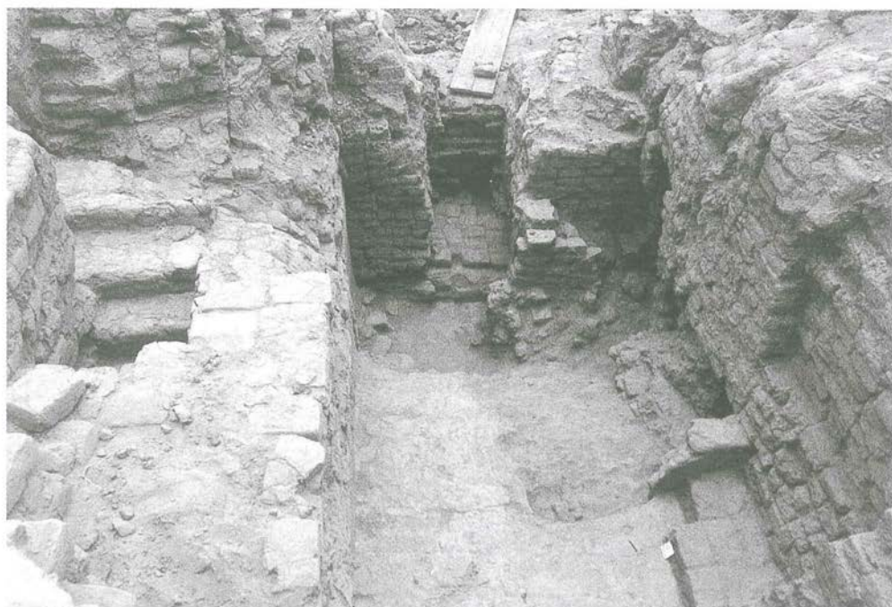
Fig. 20.17. Escalina acceso al nivel bajo desde el sexto escalón del frontis, Edificio B.
