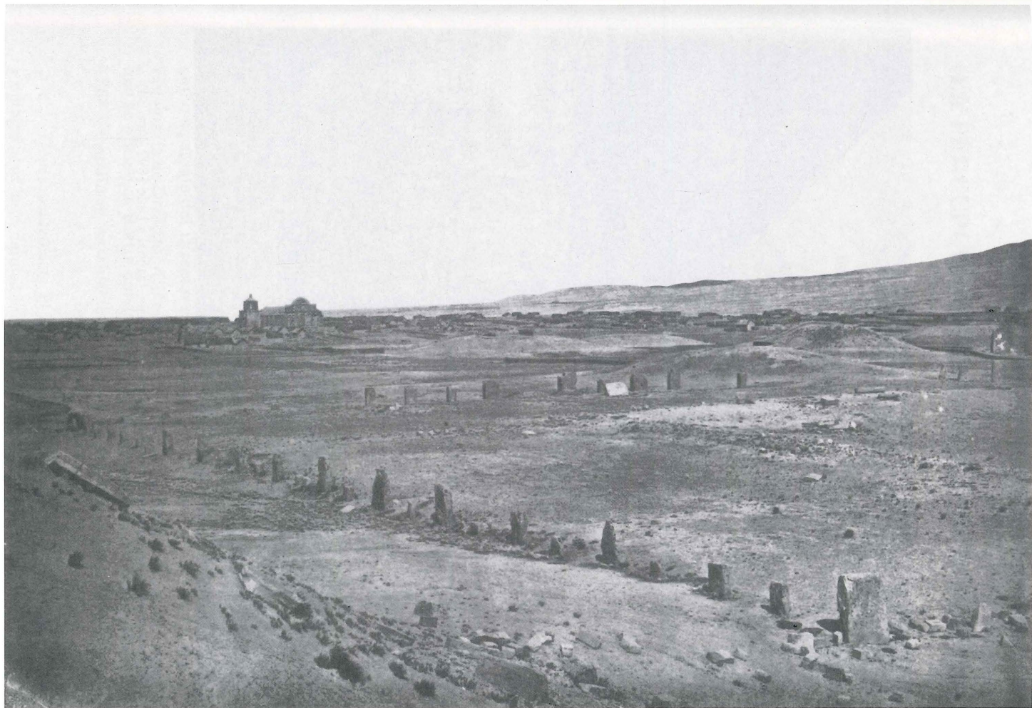
Ruinas de Akapana y el pueblo de Tiahuanaco. Vista desde el Este (Stübel y Uhle 1892, lám. 3).
