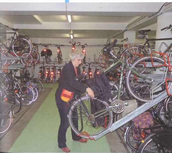
Foto 3: Instalaciones de aparcamientos de bicicletas de dos niveles con amortiguadores de gas integrados.
