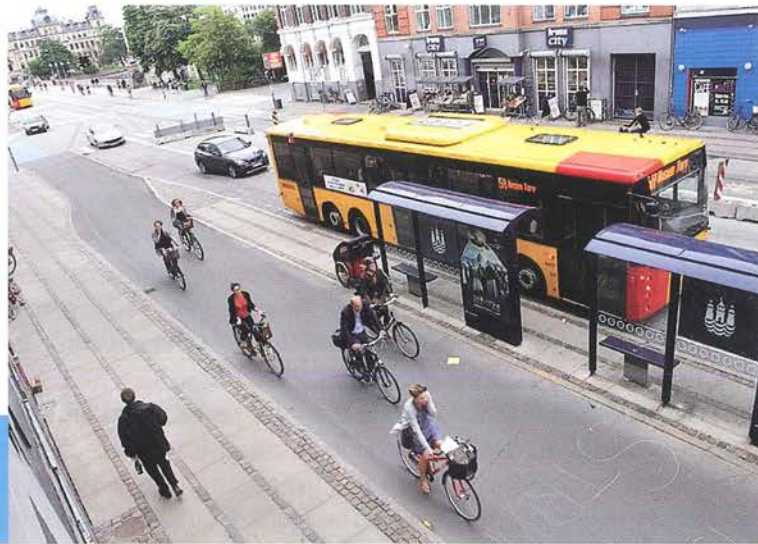
Carretera de llegada a Nørrebrogade después de la reconstrucción. Observe lo ancho de la acera y de la ciclovía.
