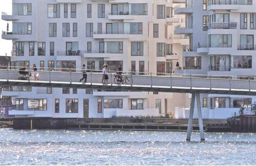
Puente peatonal y para ciclistas sobre la parte sur del puerto de Copenhague.
