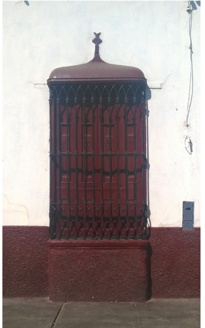
FOTO 05// VENTANA EN VIVIENDA URBANA DE SAN PEDRO DE LLOC.
