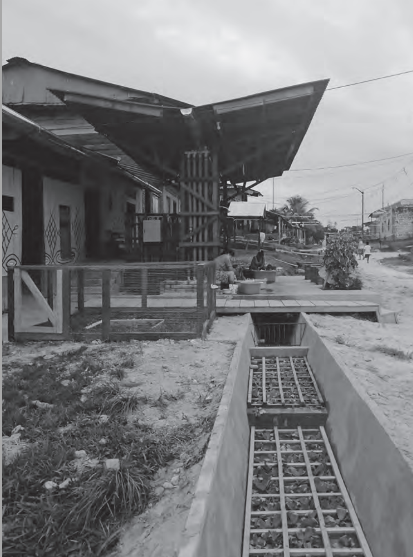
Fotografía. Fitodepurador del modelo CAT en Santo Tomás, Iquitos. Créditos: Belén Desmaison, 2020
