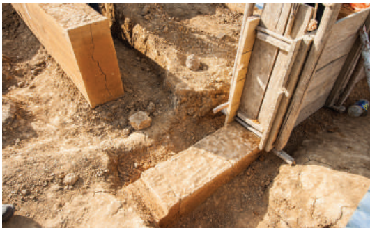
Figura 4: Nuevas construcciones con tapial, sin cimentación y con grietas por contracción. Lamas 2013. Fotografías: Augusto Román.
