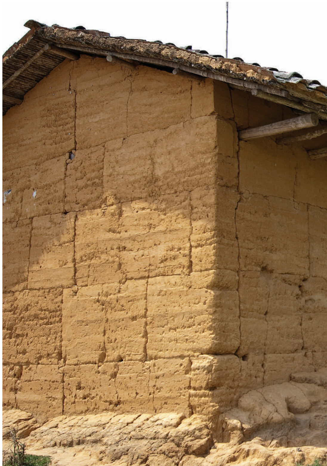
Vivienda de muro tapial con cubierta de tejas sobre estructura de madera y torta de barro sobre caña, Wayku 2013. Foto: Augusto Román.
