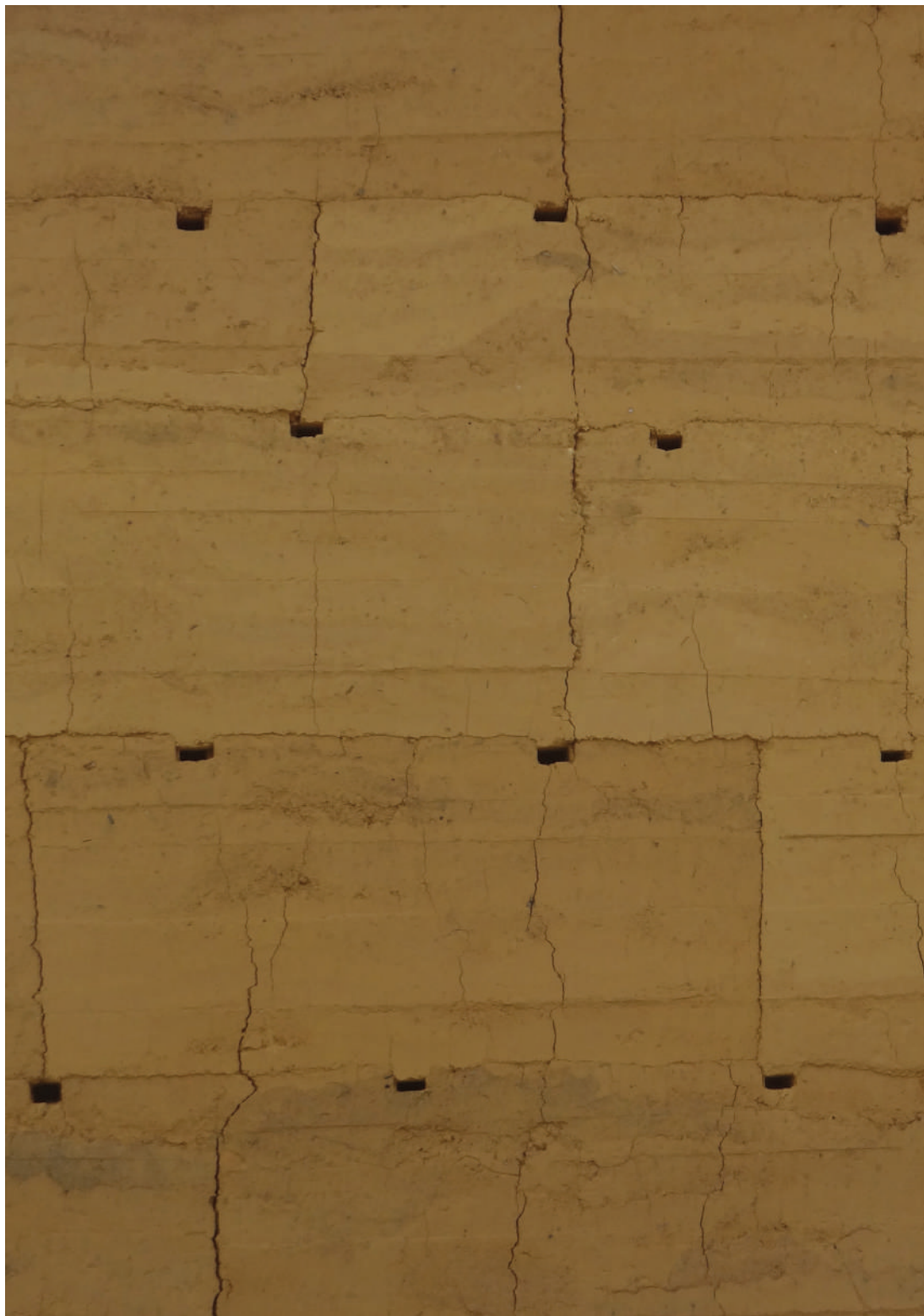
Detalle de muro de tapial en Wayku, Lamas.
