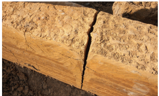
Figura 4: Nuevas construcciones con tapial, sin cimentación y con grietas por contracción. Lamas 2013. Fotografías: Augusto Román.
