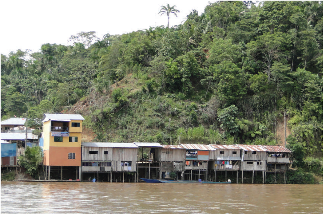
Figura 2. Viviendas a la ribera de La Tuna en Santa María de Nieva.
