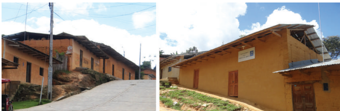
Figura 8. Desnivel del terreno. Fotografía: Teresa Montoya, 2015.
