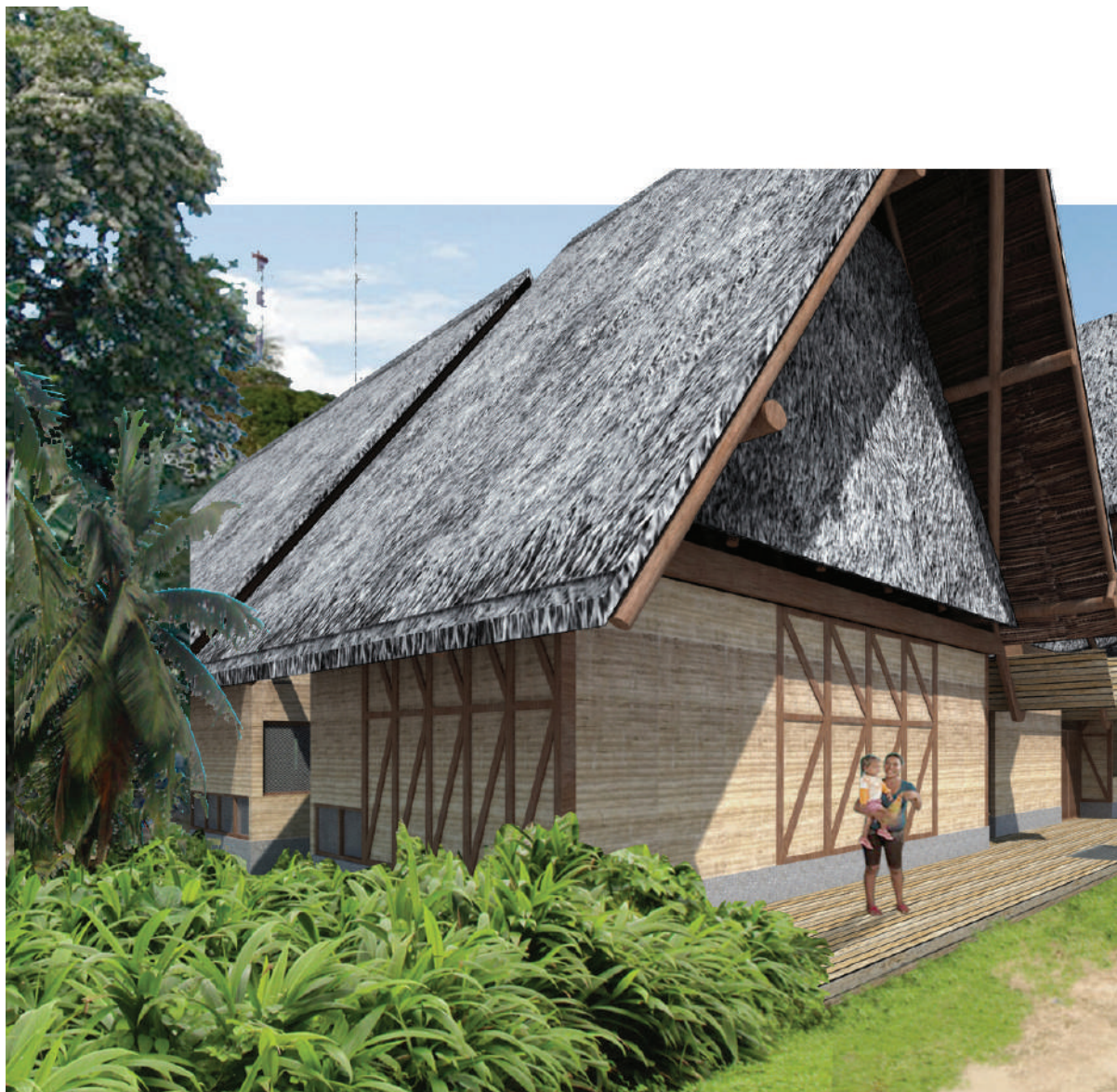
Figura 8: Vista del Centro Cuna Más desde la calle.
