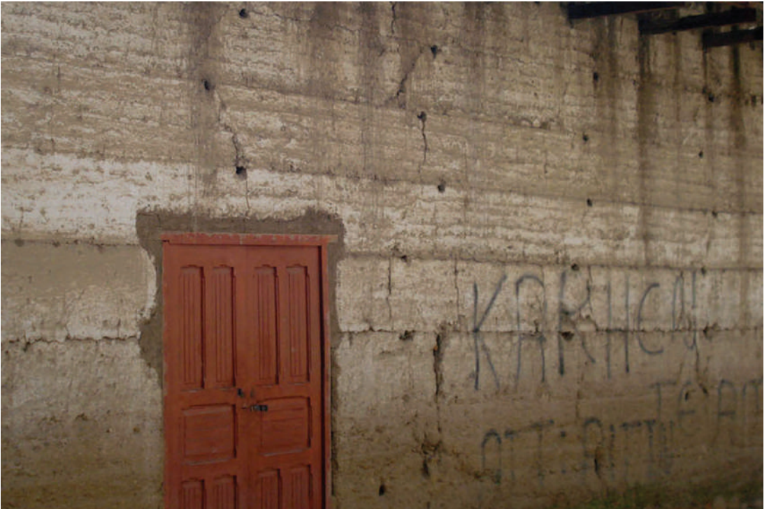
Figura 10. Detalle de muro de tapial sin enlucido. Se observan las «hiladas» de una altura aproximada de 50 centímetros (edificio en el Jr. Sánchez Carrión). Foto: Martin Wieser, 2013.
