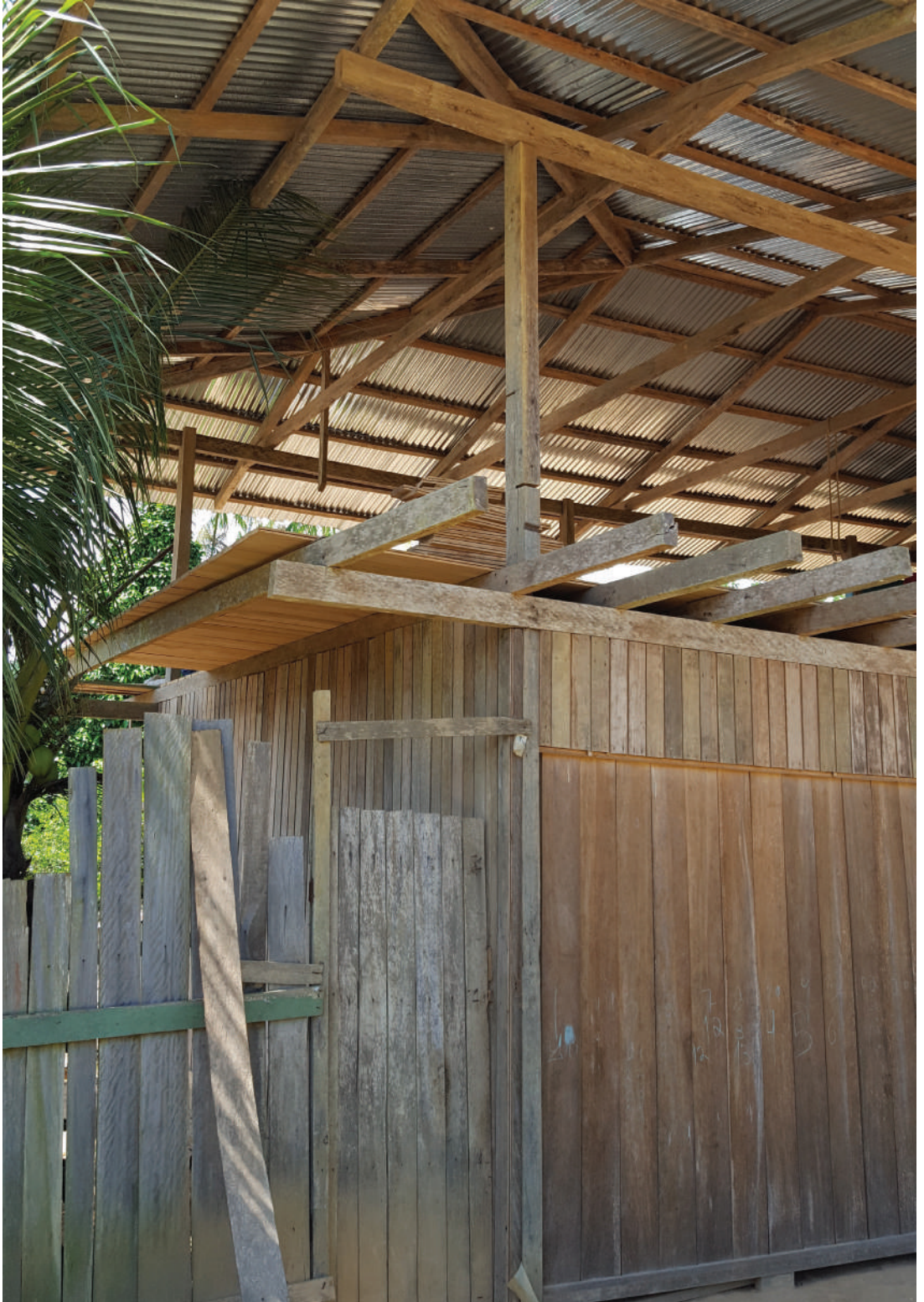
Vivienda de madera en columnas, vigas, viguetas, pares, entablado, tabiques, puertas y ventanas.
