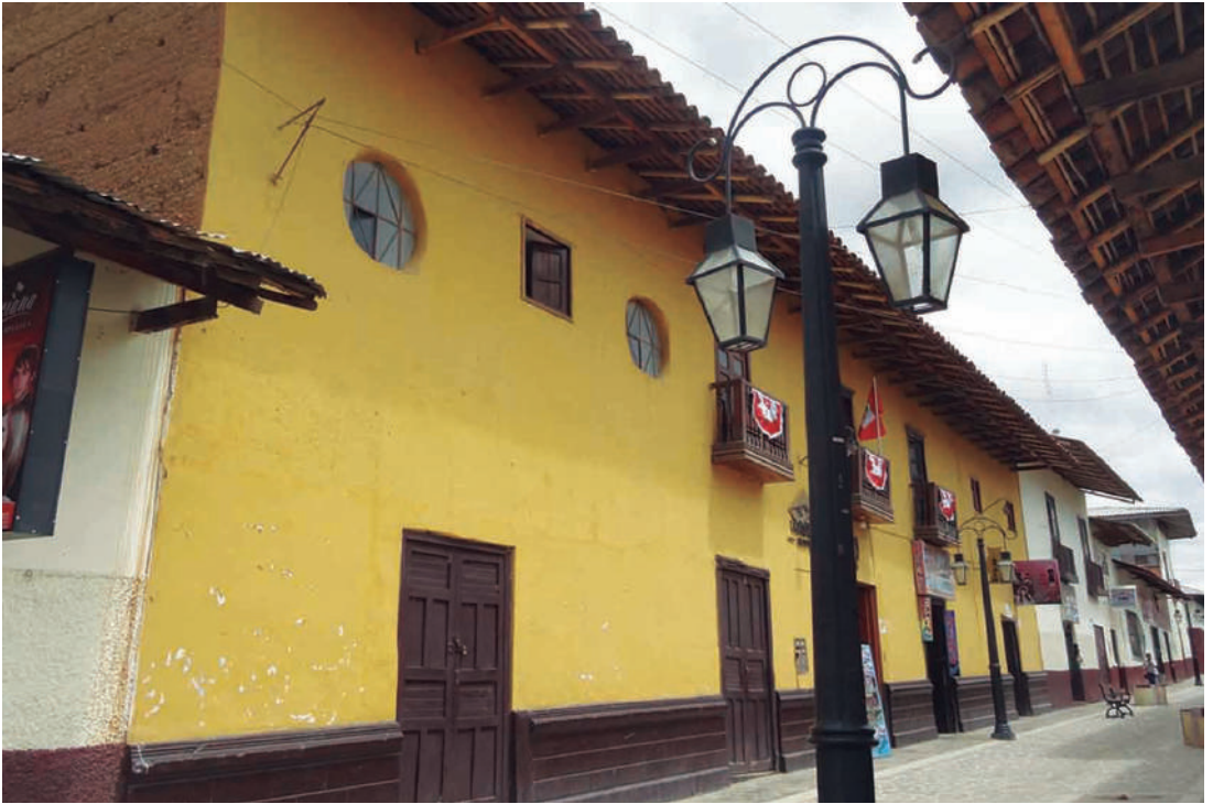
Figura 14. Edificios típicos con voladizos y «canes» (Jr. San Martín).
