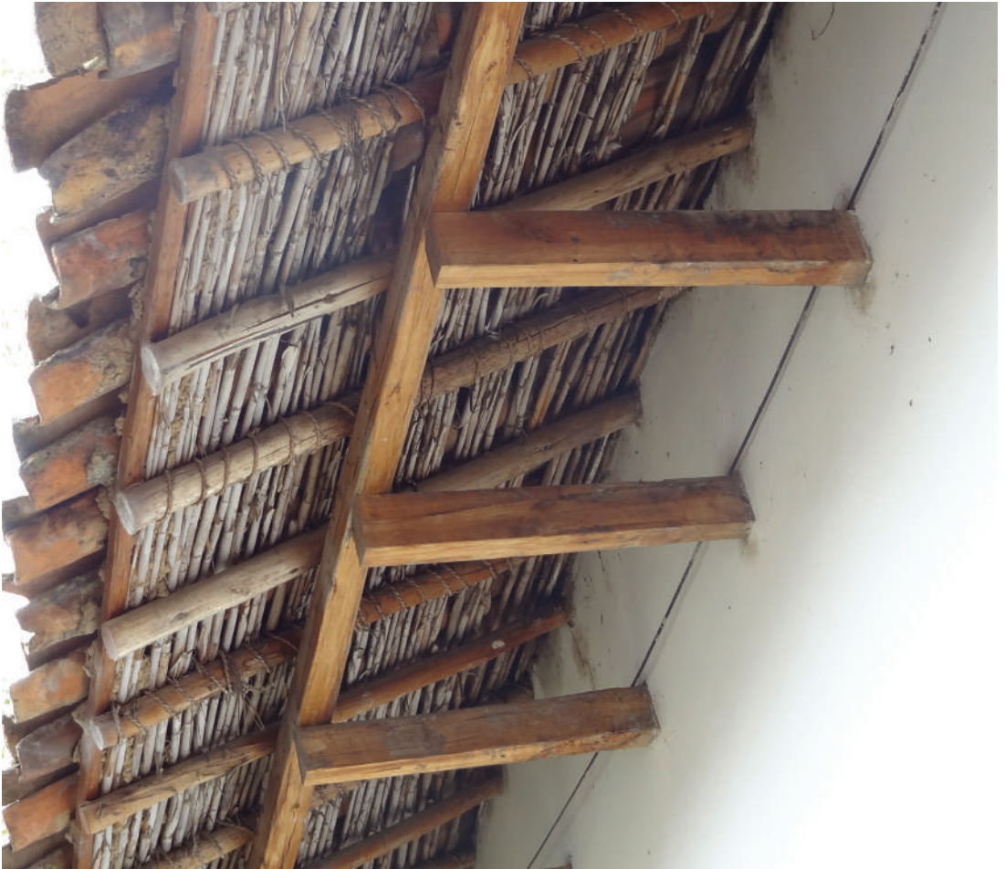
Figura 15. Sistema constructivo tradicional de alero que cubre la vereda.
