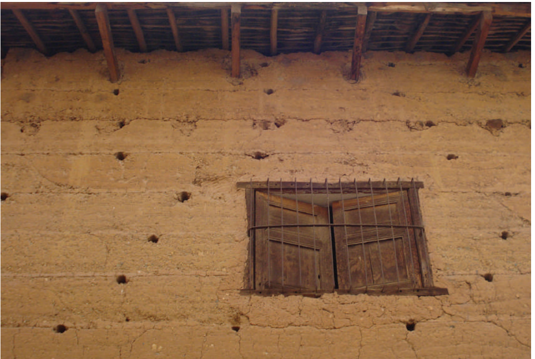
Figura 11. Detalle de muro de tapial. Foto: Martin Wieser, 2013.
