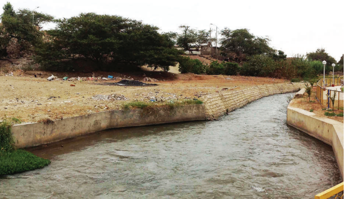
Figura 1. Vista panorámica del terreno desde la Calle Prolongación Callao y la Av. Tacna, junto al canal San Pedro Foto: Archivo proyecto Transversal, 2015.
