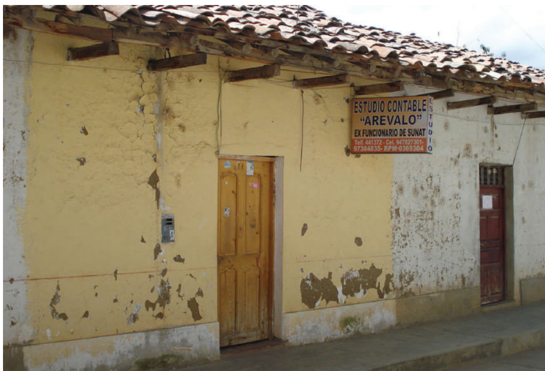
Figuras 15 y 16. Edificios de tapial sin vanos de ventanas hacia la vía pública (jirones San Martín y Suárez). Fotografías: Martín Wieser, 2013.
