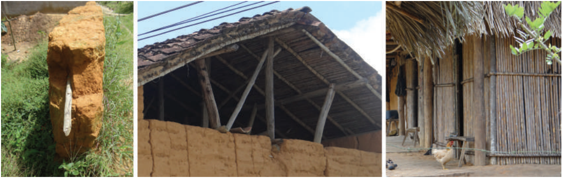
Figura 2. Maderas utilizadas para los techos y maderas y cañas utilizadas en los muros de quincha.
