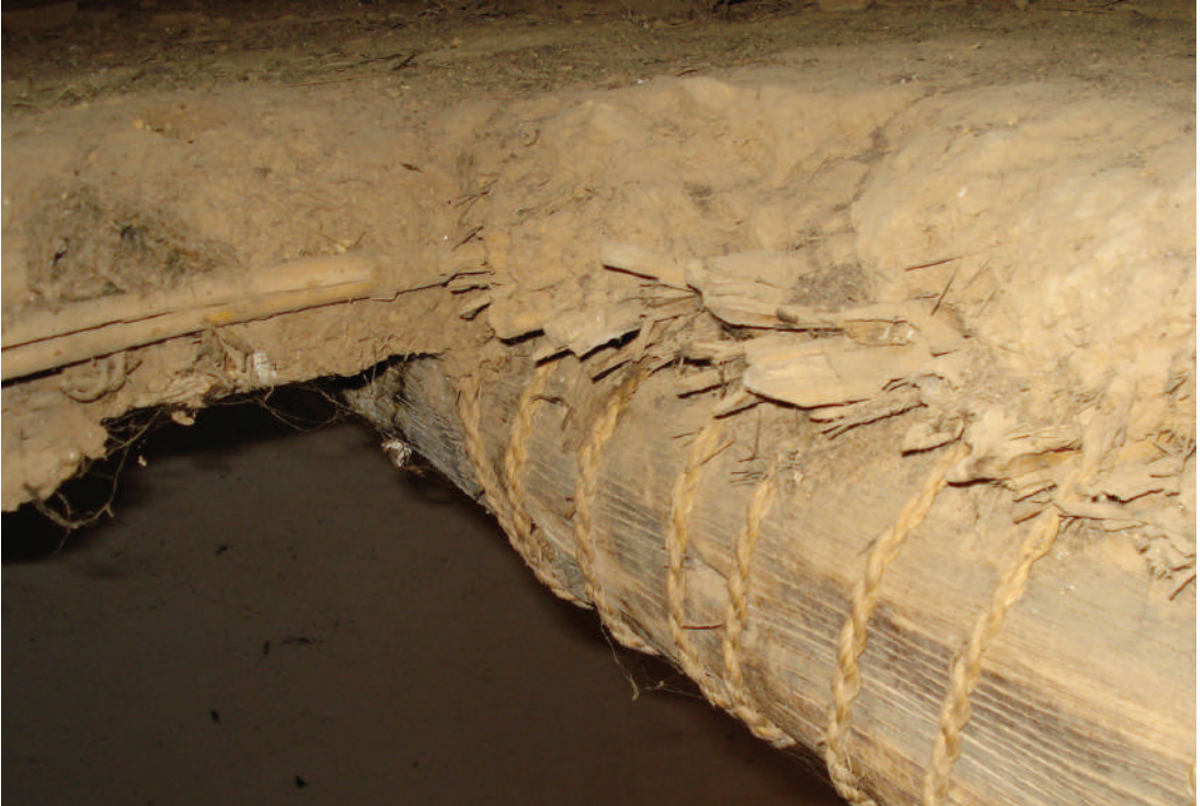
Figura 13. Detalle del «entretecho» con torta de barro sobre cañas. Foto: Martin Wieser, 2013.
