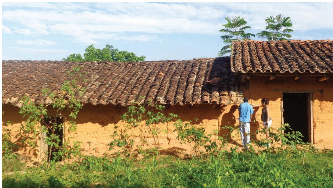
Figura 6. Detalles de vivienda tradicionales en Wayku, Lamas.
