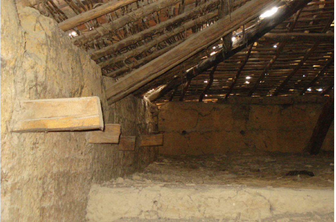
Figura 12. Vista del ático con viguetas apoyadas sobre el muro de tapial y «canes» empotrados. Foto: Martin Wieser, 2013.
