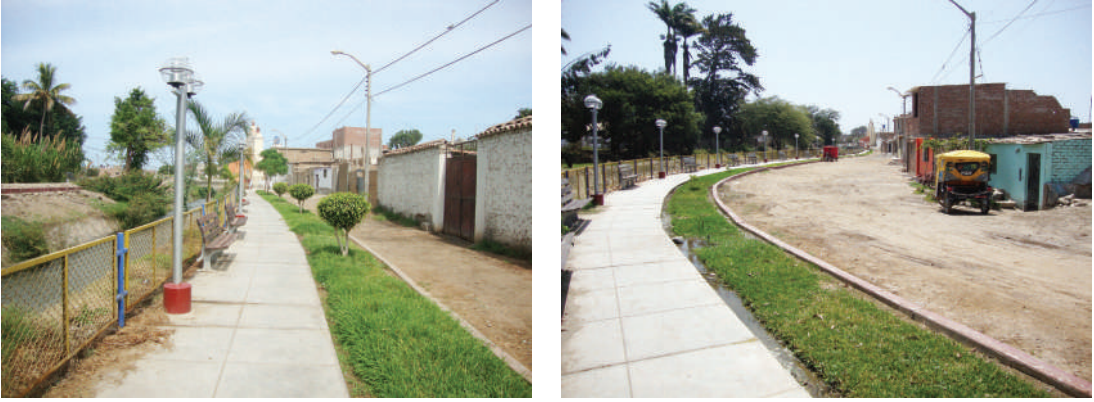
Figura 4. Situación actual de la Av. Tacna. Fuente: Archivo proyecto Transversal, 2016.
