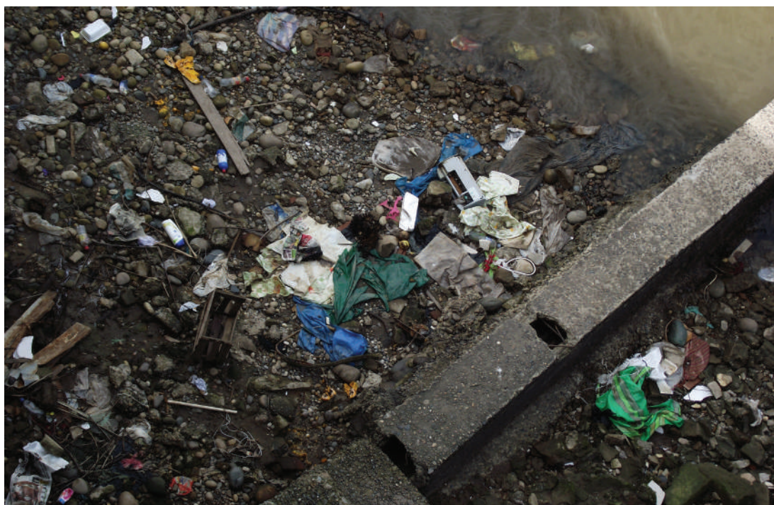
Figuras 20 y 21: La pérdida del cuidado de las fuentes de agua en Lamas y Nieva. Emisor de aguas residuales de la ciudad de Lamas (arriba). Desagues y basura en el río Maraón (abajo). Fotografías: Gustavo Rondón.
