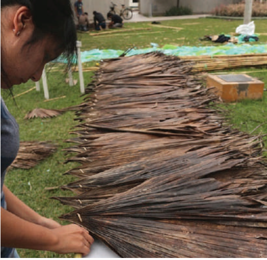
Figura 5. Preparando, para techar, las hojas de palmera bombonaje ( Iriartea deltoidea ) traídas desde el Alto Marañón. Fotografía: Blanco & Negro, 2013.
