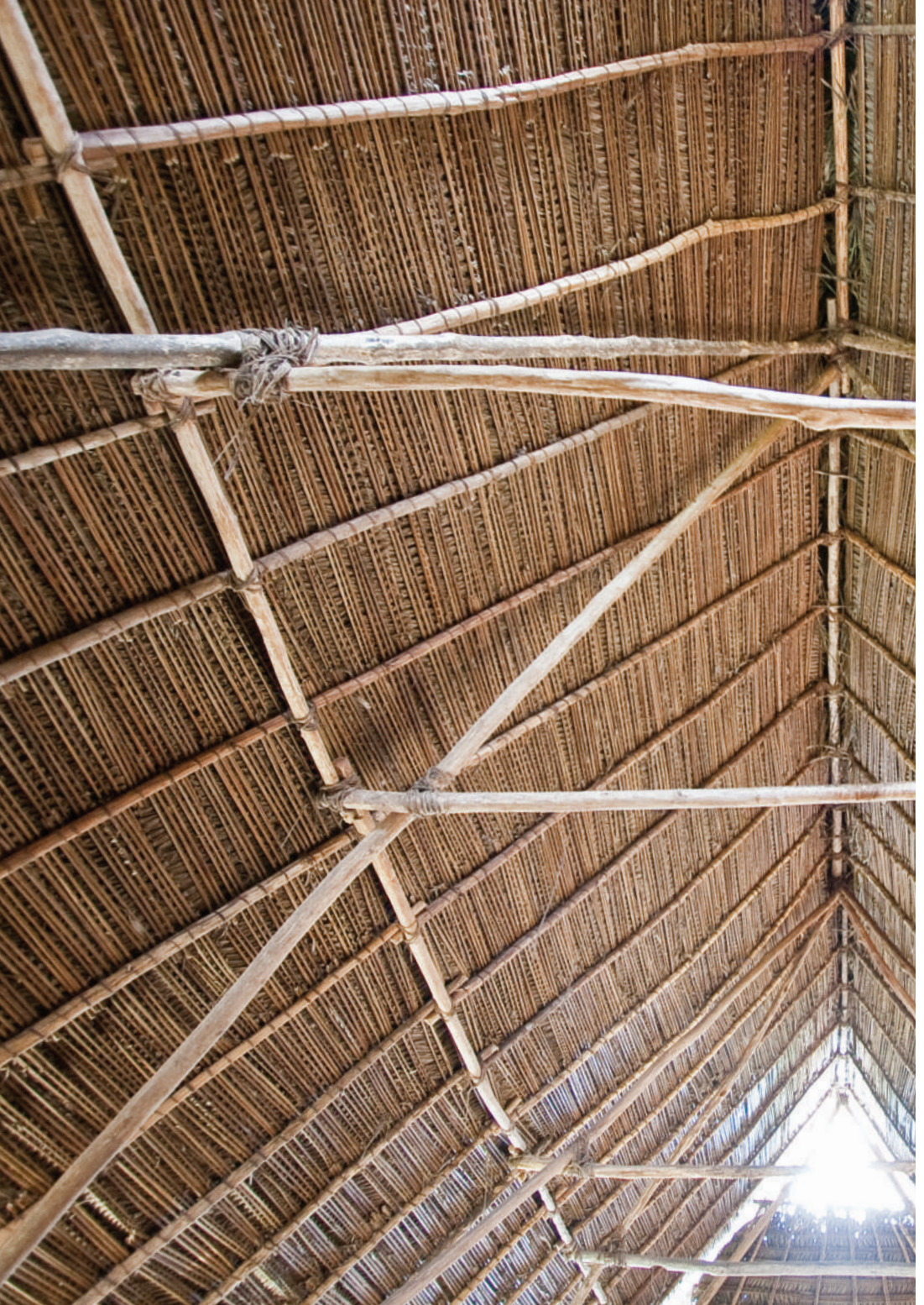
Techo de hoja de palmera con estructura de madera, salón comunal de Congopera, 2013.
