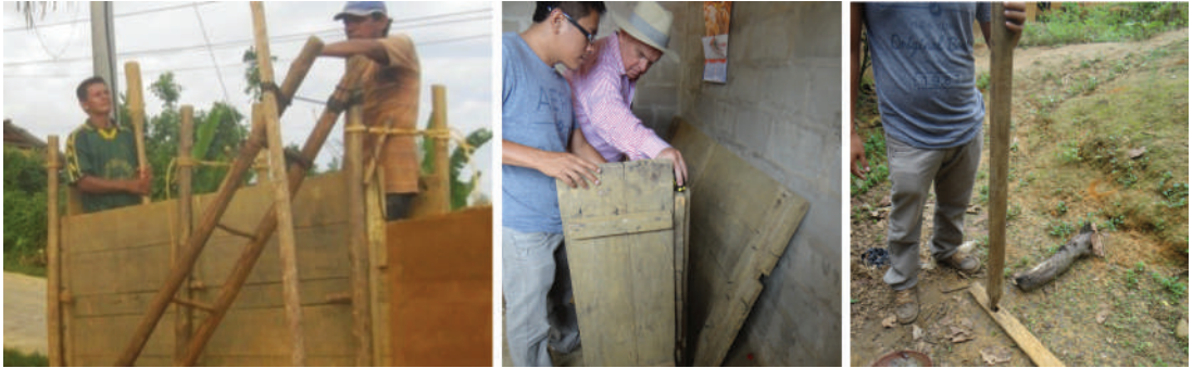
Figura 4. Izquierda: Encofrado armado. Fotografías: Werlin Guerra, 2013.
