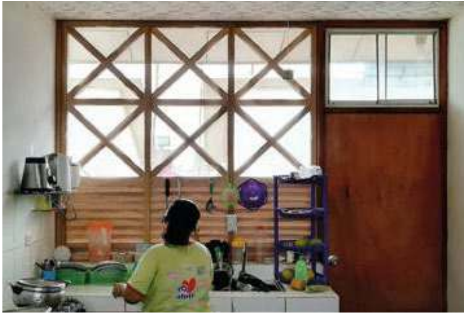
Figura 4.8. Ventana de madera y mosquitero adaptada para usos en una cocina en una vivienda familiar. Imagen del equipo de CASA
