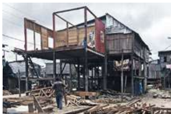
Figura 4. Demolición de vivienda en la Zona Baja de Belén. Cortesía del equipo de CASA. Figure 4. Demolition of the house in Zona Baja de Belén. Courtesy CASA team.
