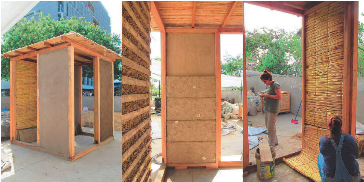
Figura 2. Vista del módulo con los cuatro paneles de quincha conteniendo las propuestas de mejora de desempeño térmico
