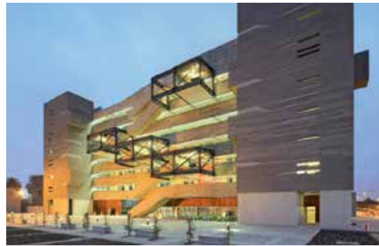
b) Aulario de Ingeniería, Campus PUCP
