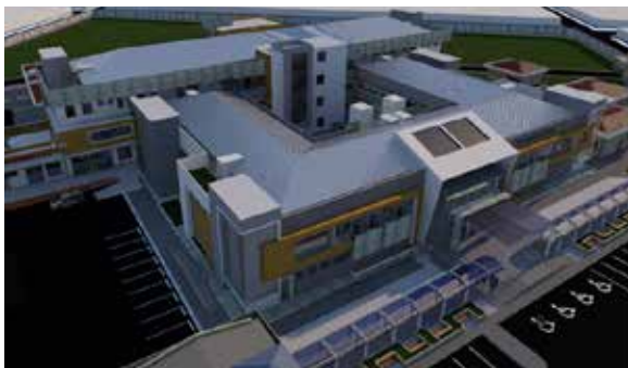
a) Hospital de Llave, una sola interface de aislamiento para una manzana de edificios
