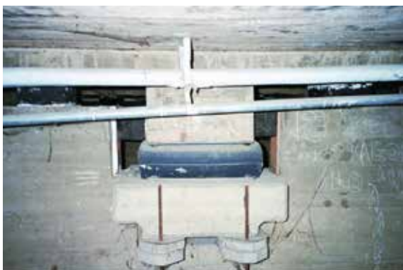
a) Aislador del primer edificio aislado con dispositivos de goma, 1969, Colegio Pestalozzi, antigua Yugoslavia.
