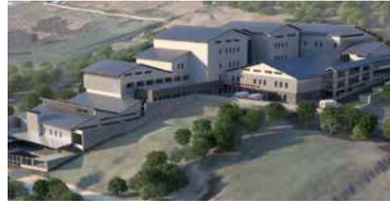
b) Hospital de LLata. con interfaces de aislamiento en distintos niveles.
