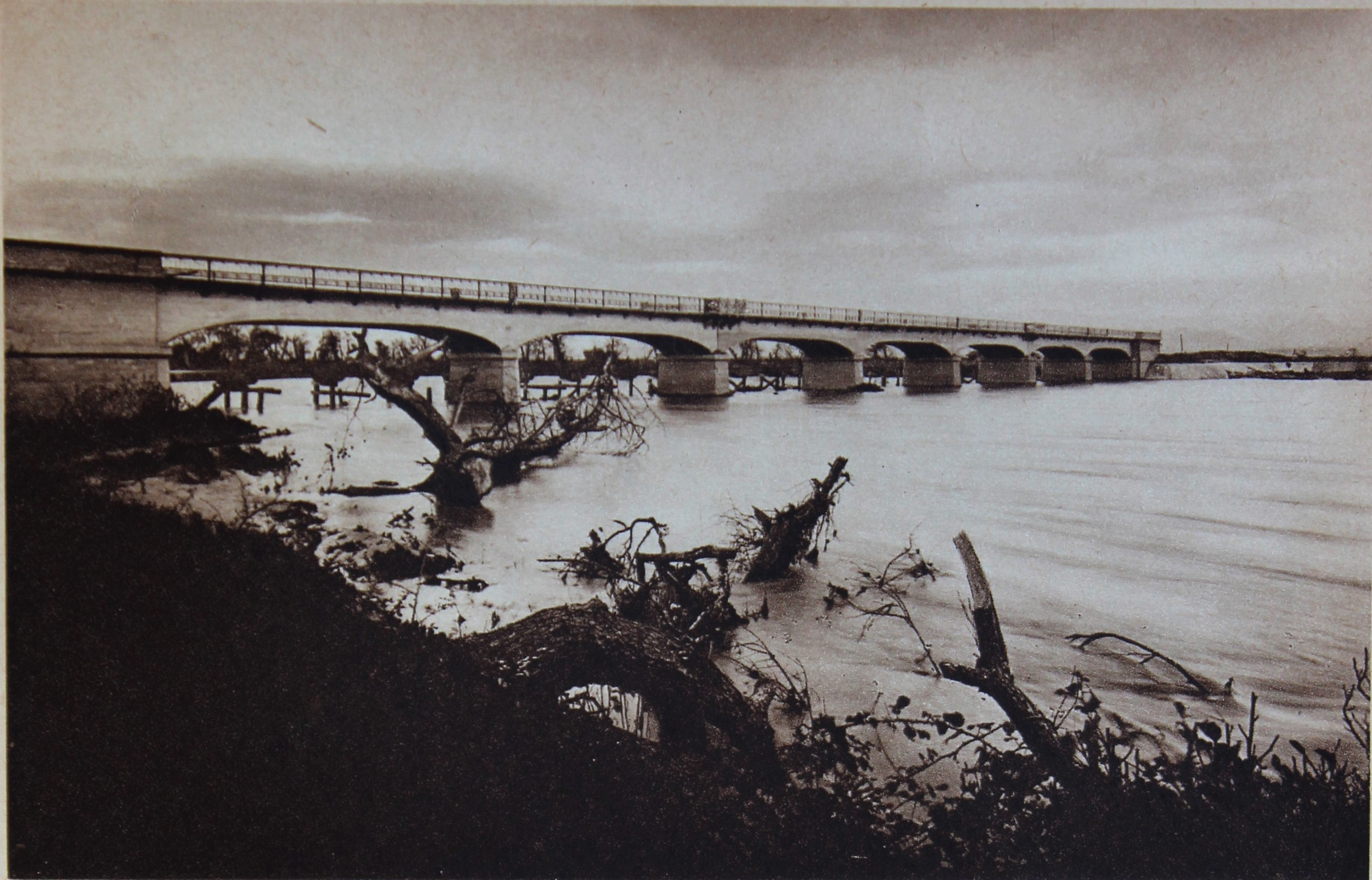
La bonifica è impresa audace e faticosa e complessa. Al risanamento della terra occorrono strade, ponti, case. Nulla arresta il Regime in questa gloriosa fatica. Ecco nella bonifica di Sibari un ponte sul fiume Crati che è fra i più lunghi d'Italia: 164 metri in sette arcate.
