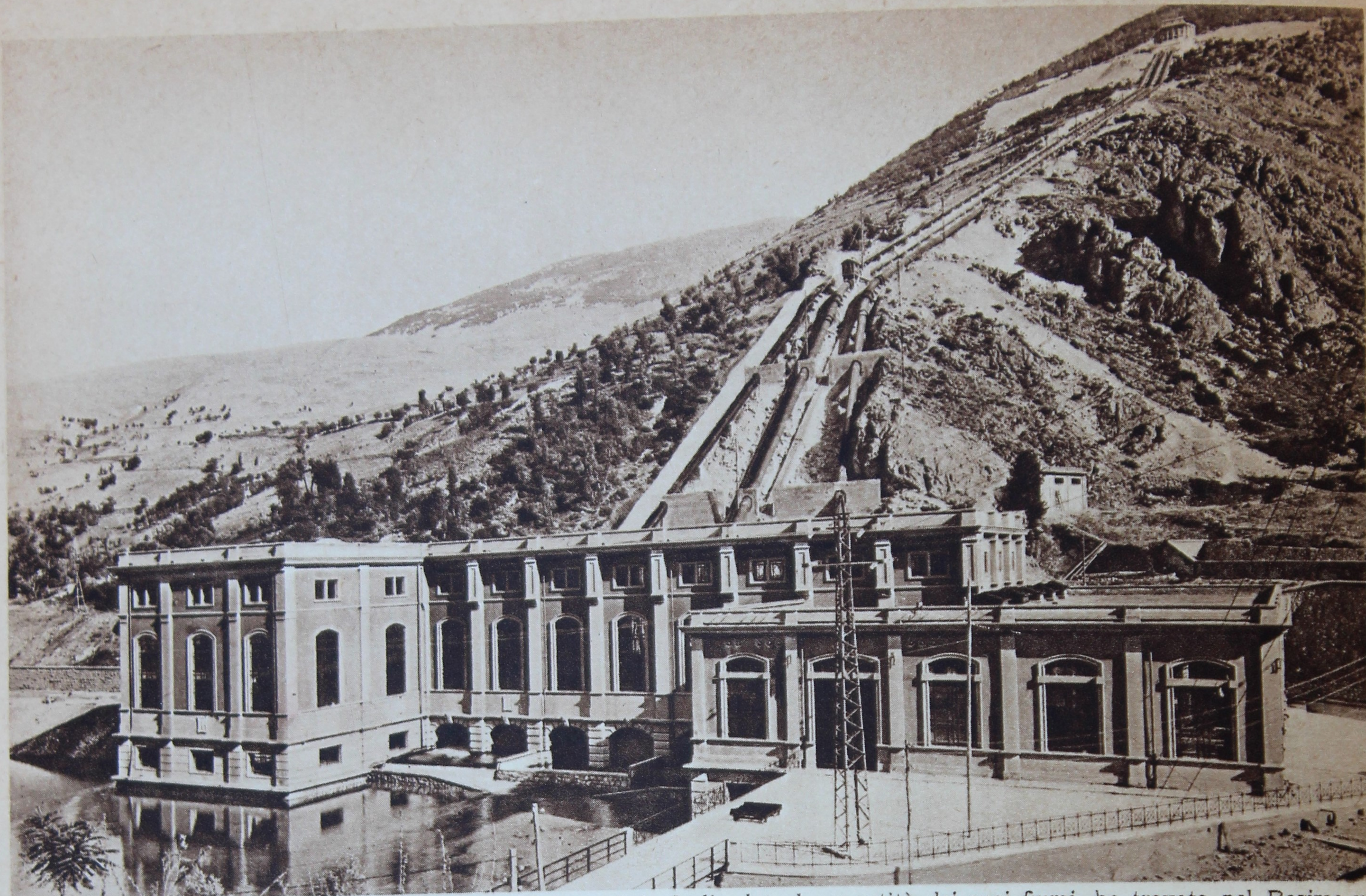
L'industria elettrica, che è una delle ricchezze più notevoli in Italia data la quantità dei suoi fiumi, ha trovato nel Regime un potente impulso. Ecco, fra i molti, l'impianto idroelettrico del Sagittario (edificio della Centrale) presso Anversa degli Abruzzi. Il Fascismo ha iniziato così la nostra emancipazione dall'estero verso il quale siamo tributari per il carbone.
