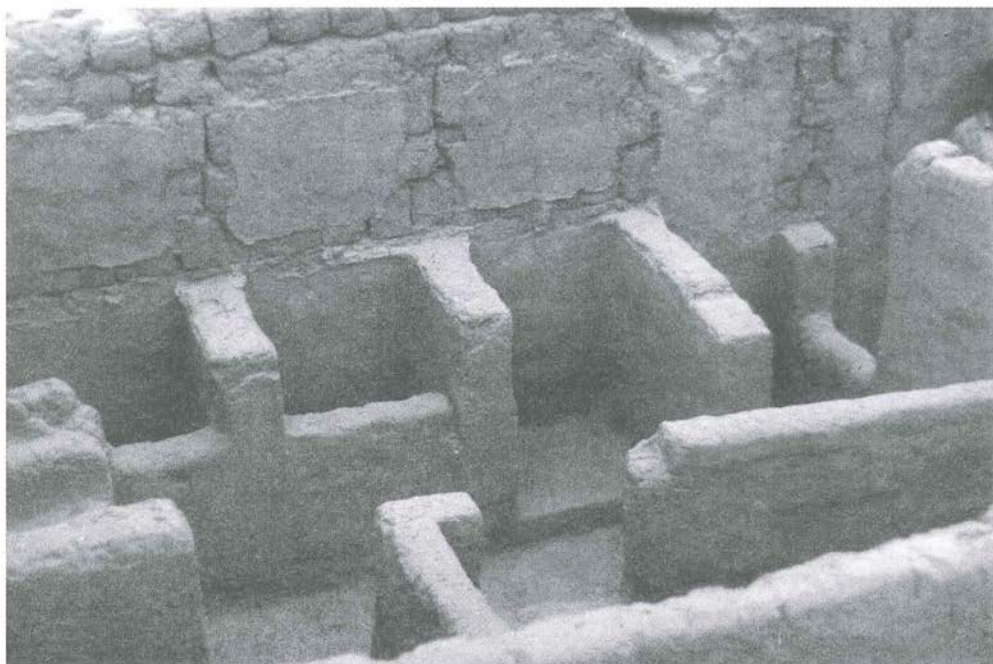
Fig. 4.10. Vista desde el oeste de la fila de tres arcones, localizados en el lado este de la esquina del recinto de almacenamiento. El patrón del enlucido del muro que está detrás de estos arcones indica que tuvieron cubiertas, y que hubo una segunda fila de tres arcones encima de los que están preservados.
