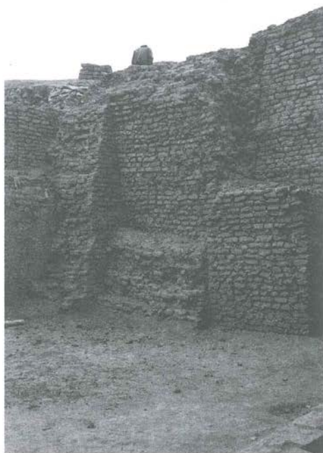
Fig. 3.12. Bloques de adobes tramado (BAT) que cubren los recintos del Edificio D.
