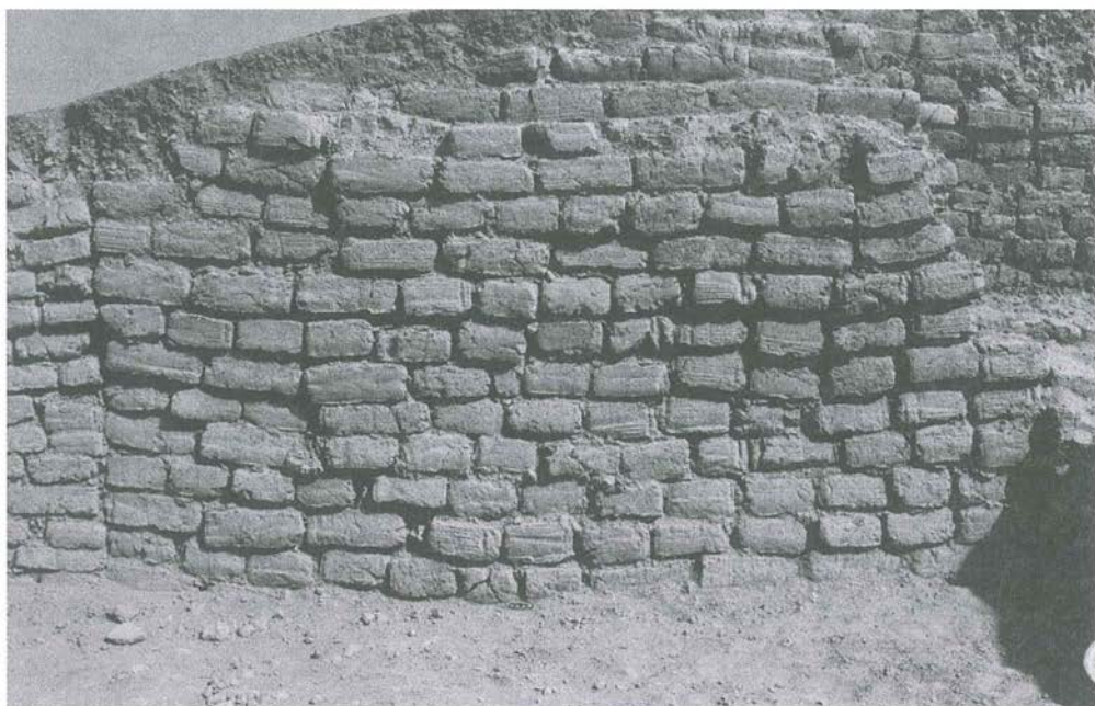
Fig. 3.15. Aparejo irregular de un bloque de adobes tramado.
