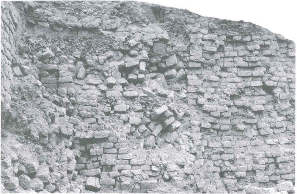
Fig. 3.23. Relleno de adobes desordenados entre dos bloques de adobes tramado.
