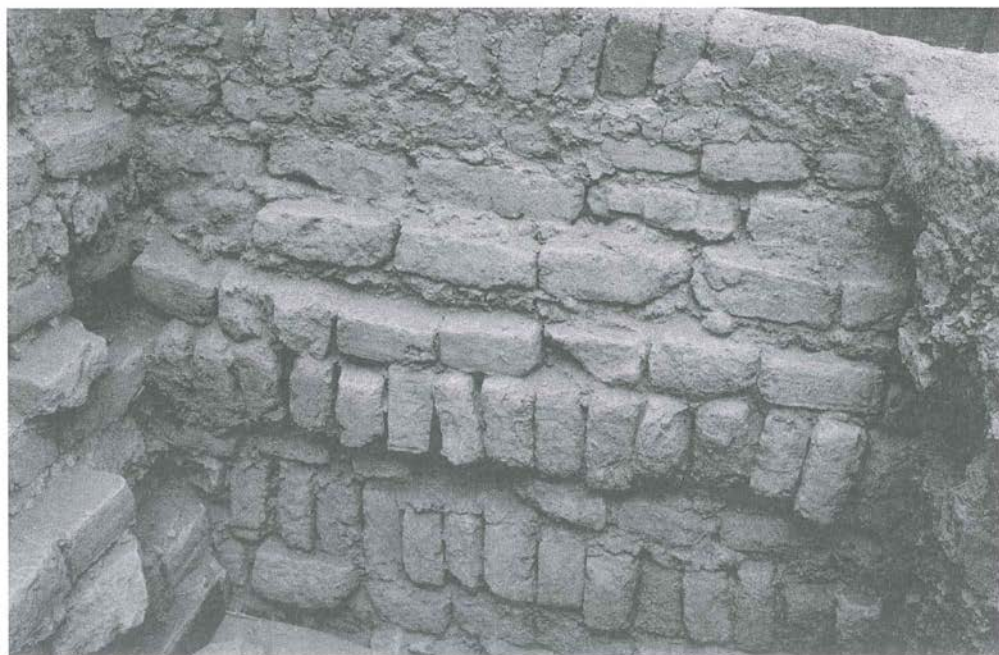
Fig. 3.16. Adobes colocados de canto en el Edificio A.
