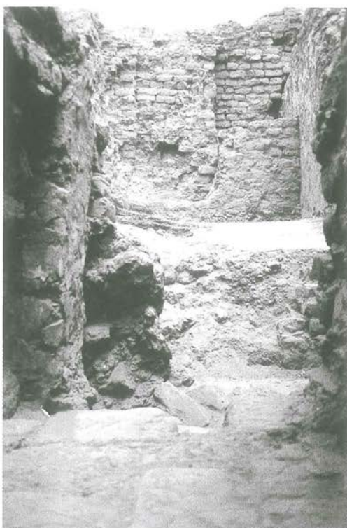
Fig. 20.16. Vano y rampa acceso al nivel superior desde el quinto escalón del frontis, Edificio C.
