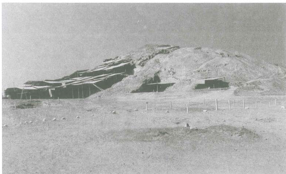
Fig. 19.2. Panorámica de la Huaca Cao Viejo en su estado actual.
