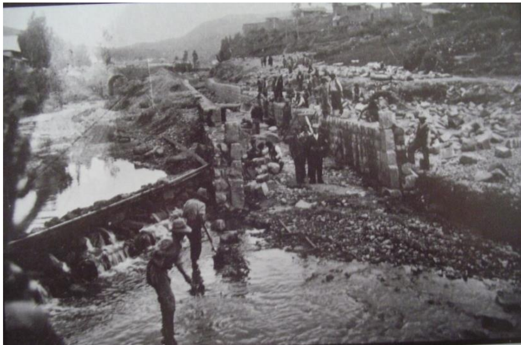
Imagen 7. Vista de trabajos complementarios cerca de los baños de Saphy en 1948
