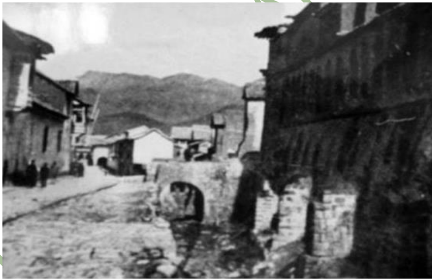
Imagen 5. Canalización de la tercera sección de la Compañía de Jesús, Santa Teresa
