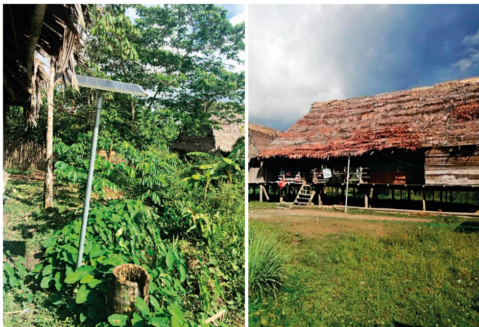
Figura 24. Paneles solares en viviendas de Villa Belén
