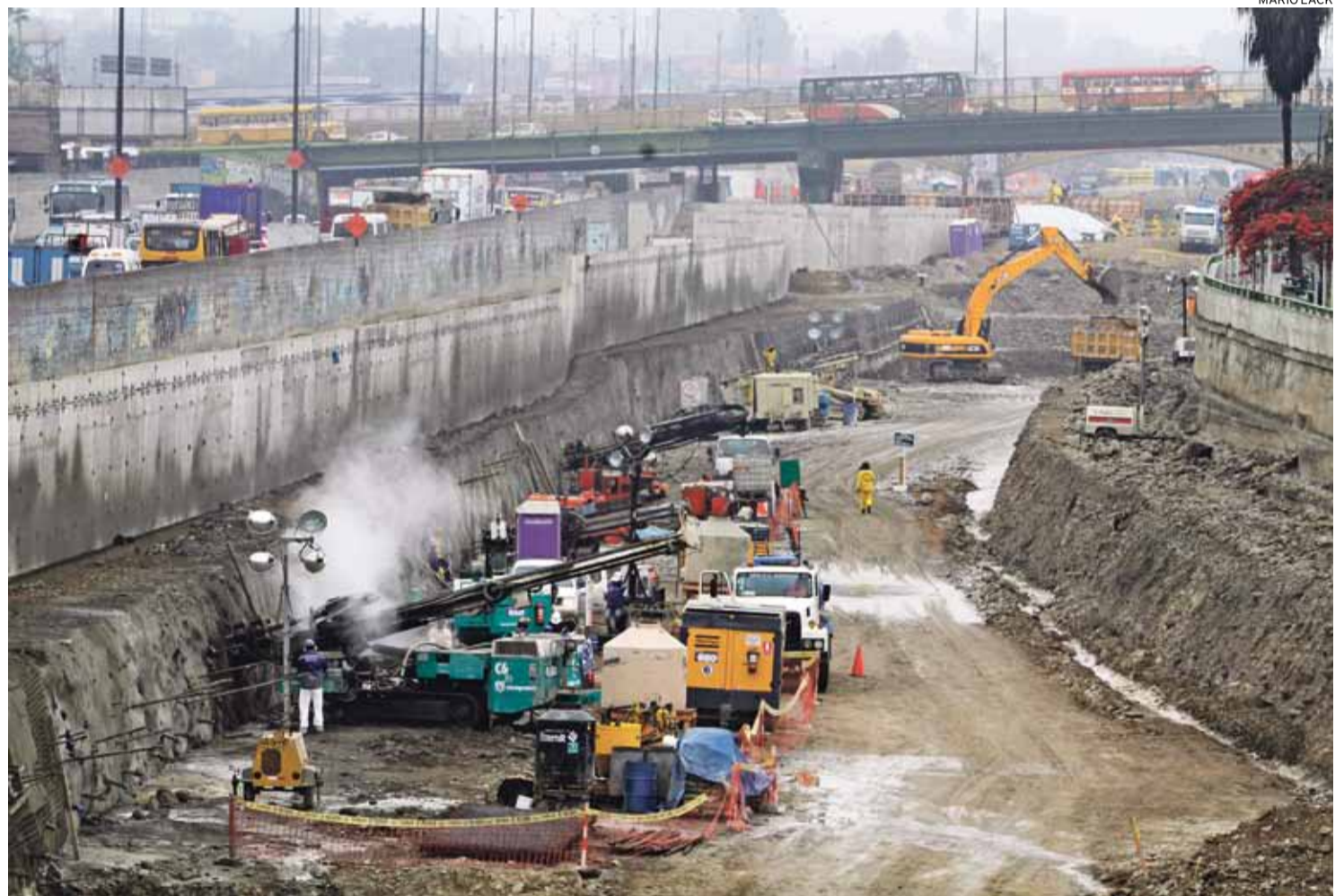
NUEVA ARTERIA VIAL. A la altura del puente Huáscar se está construyendo un túnel de 2 kilómetros que pasará por debajo del río Rímac.
