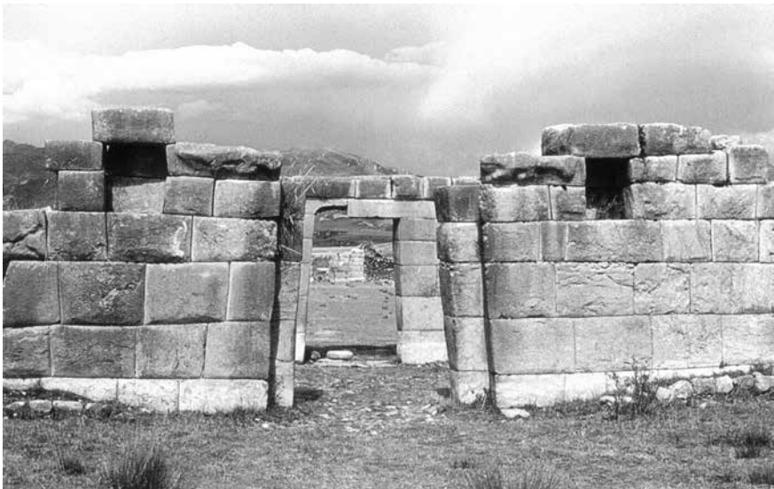
Figura 17. Portadas de piedra canteada en la entrada a IIB2
