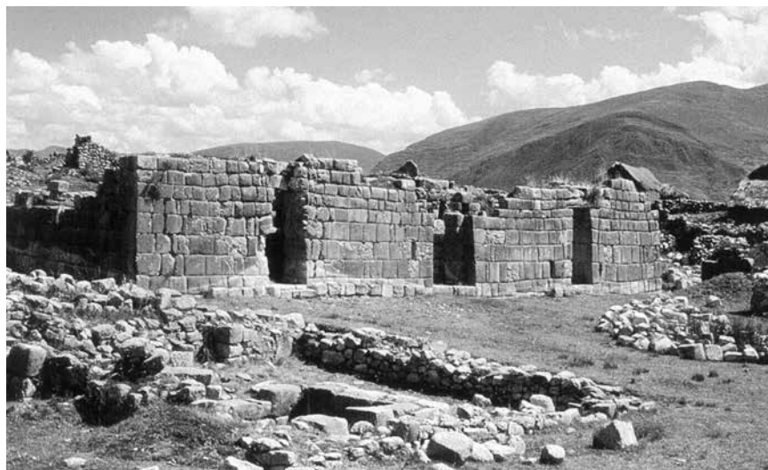
Figura 15. Estructuras de aparejo de piedra labrada que habrían sido hospedajes para la realeza. Sector IIB4 de Huánuco Pampa
