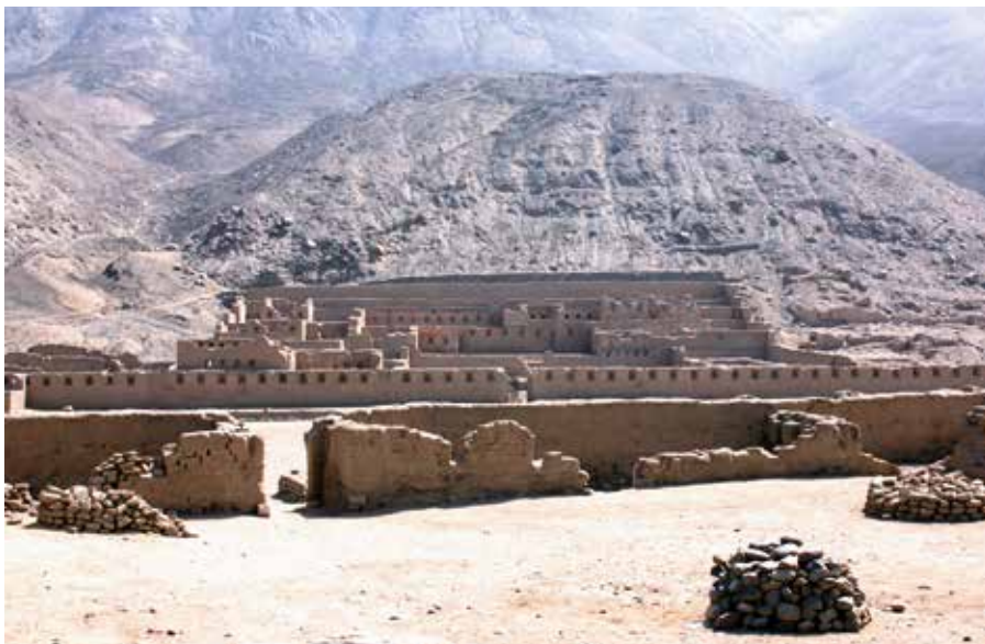
Figura 30. Vista del Palacio Noroeste de Tambo Colorado tomada desde el suroeste
