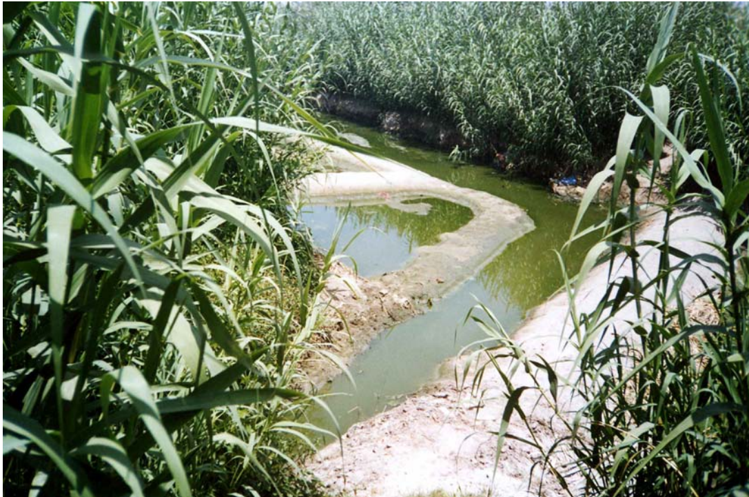
Aguas servidas que desembocan en el canal.
