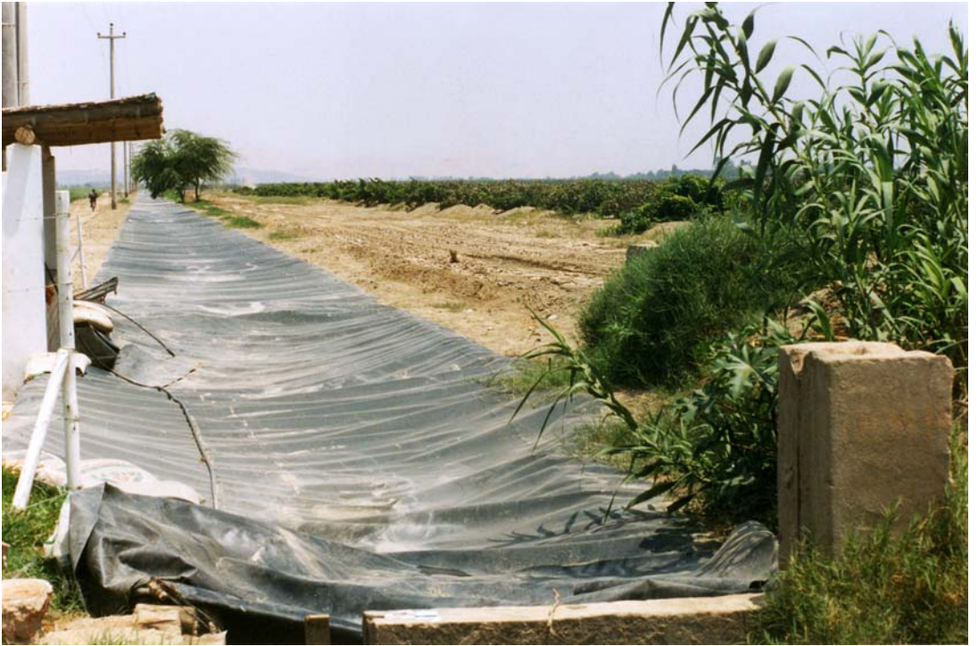
Canal de riego cubierto para evitar la evaporación e impurezas. El agua es conducida a las pozas de almacenamiento de agua.
