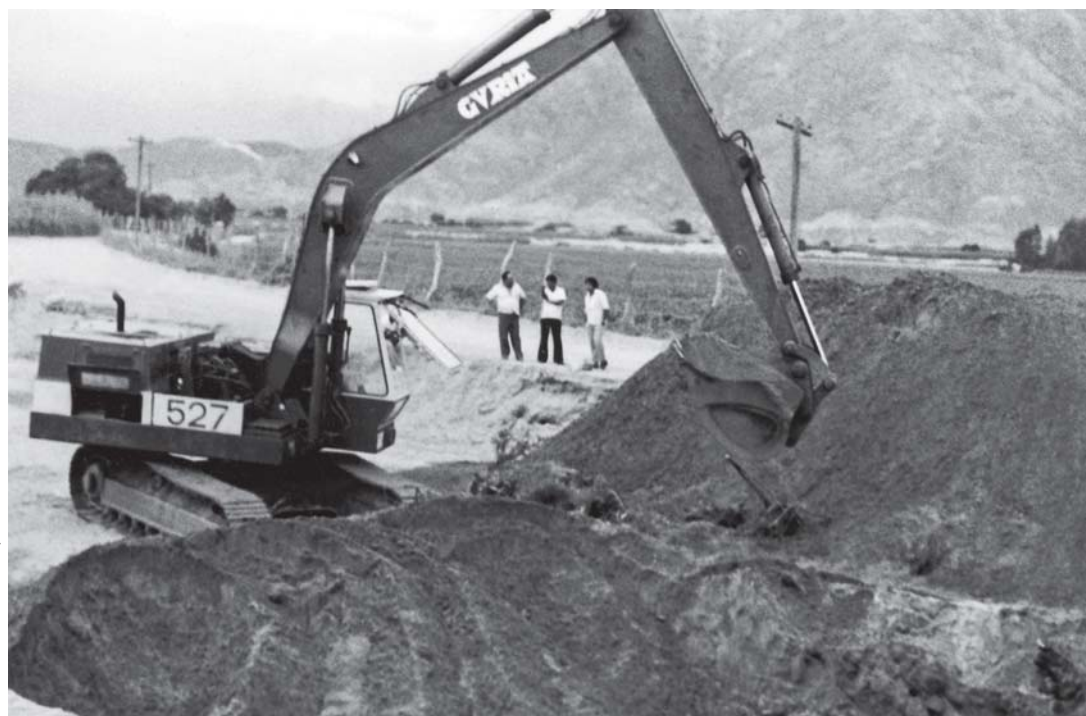
Incorporación de moderna máquina retroexcavadora para la limpieza del canal.
