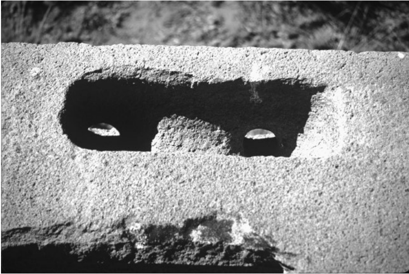
Figura 6.17. Perforación para izamiento.
