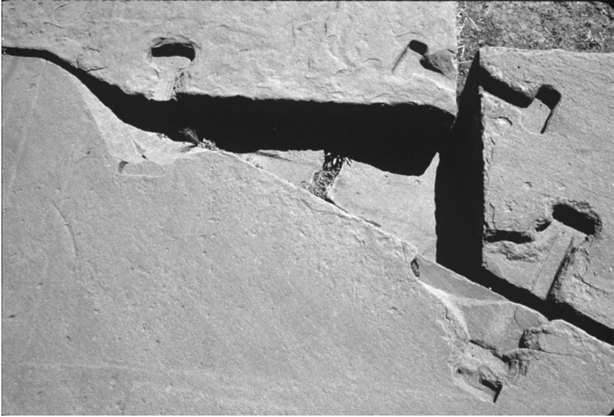
Figura 6.25. Ranuras para grapas en la Plataforma III en Pumapunku.
