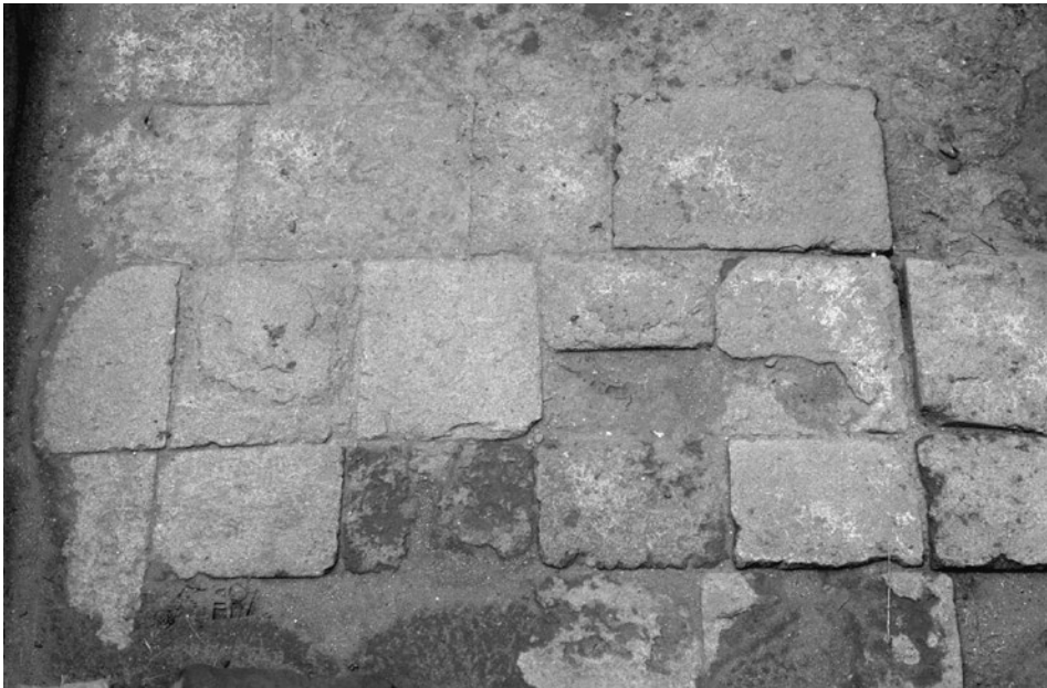
Figura 6.21. Pavimentación del patio central de Pumapunku.
