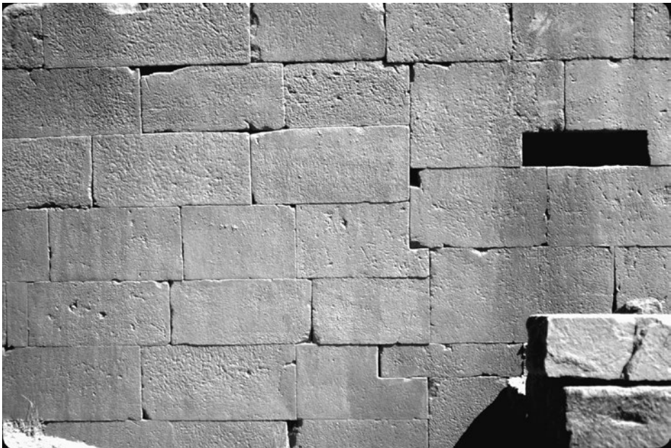
Figura 2.12. Mampostería de aparejo casi regular del tercer muro del lado este de Akapana.
