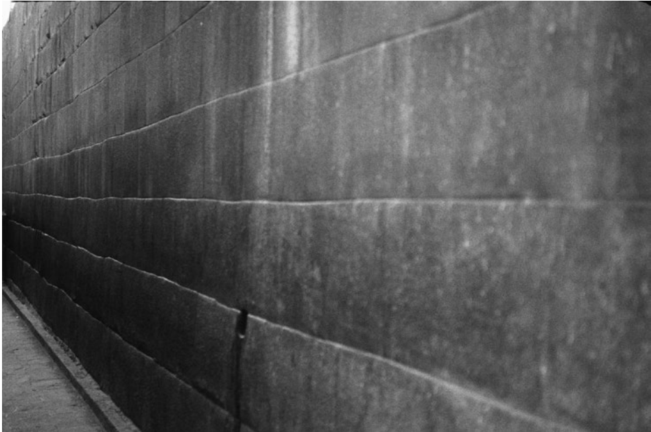
Figura 2.71. Juntas horizontales ondeadas en la mampostería de sillar inca.
