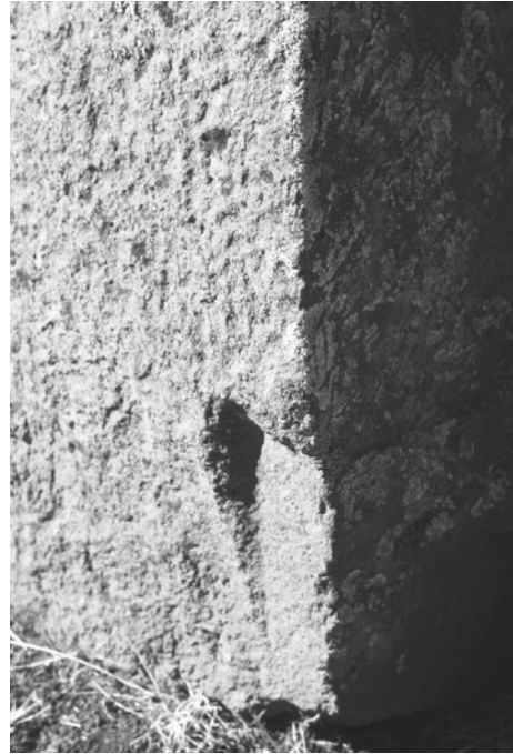
Figura 5.16. Nótese cómo una superficie aplanada es transferida a la cara adyacente de un bloque de piedra.
