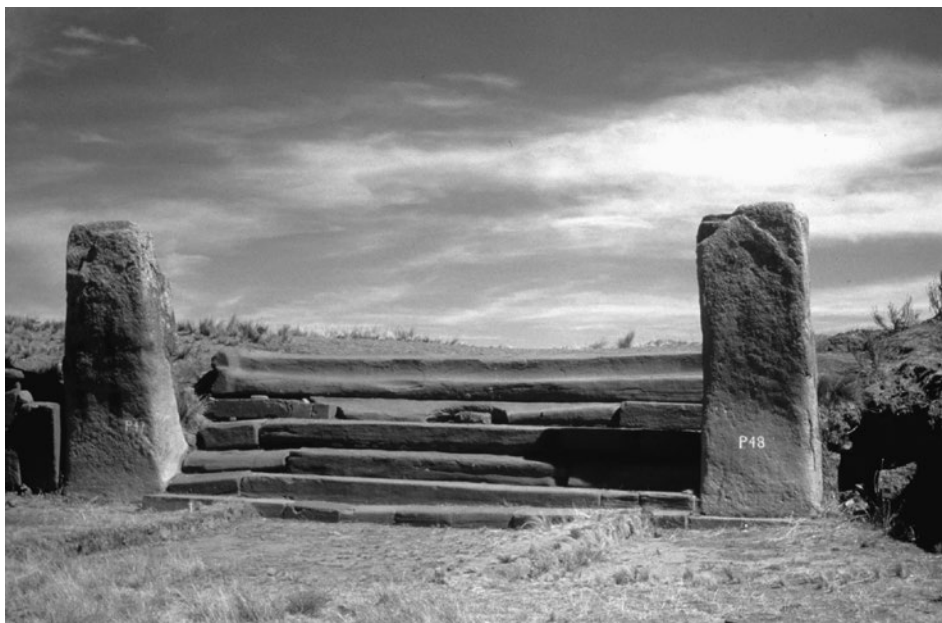
Figura 2.32. Escalera al este de Kalasasaya antes de la reconstrucción (fotografía anónima).
