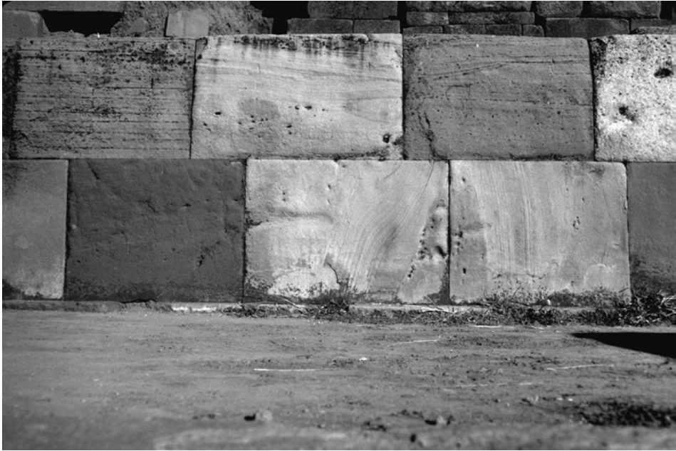
Figura 2.11. Opus quadratum del segundo muro.
