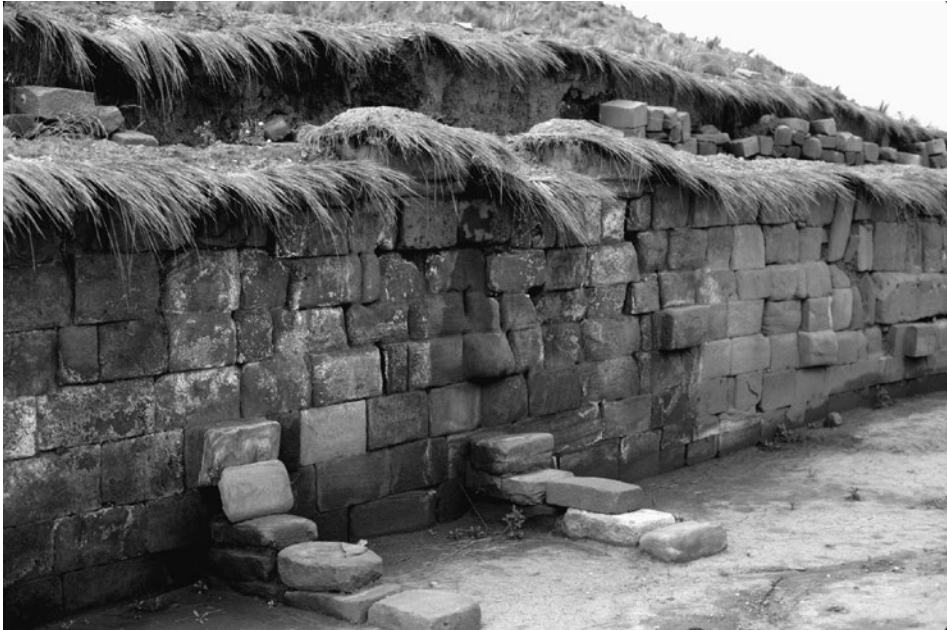
Figura 2.19. Segundo muro con contrafuertes en el lado sur de Akapana.
