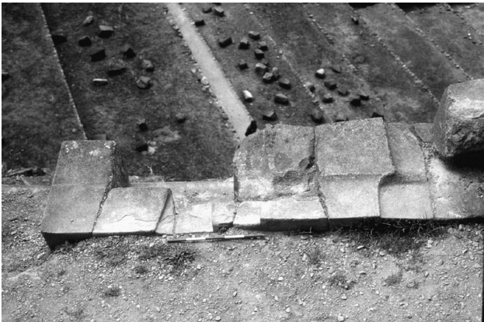
Figura 2.72. Huellas dejadas por las piedras extraídas de la mampostería inca.
