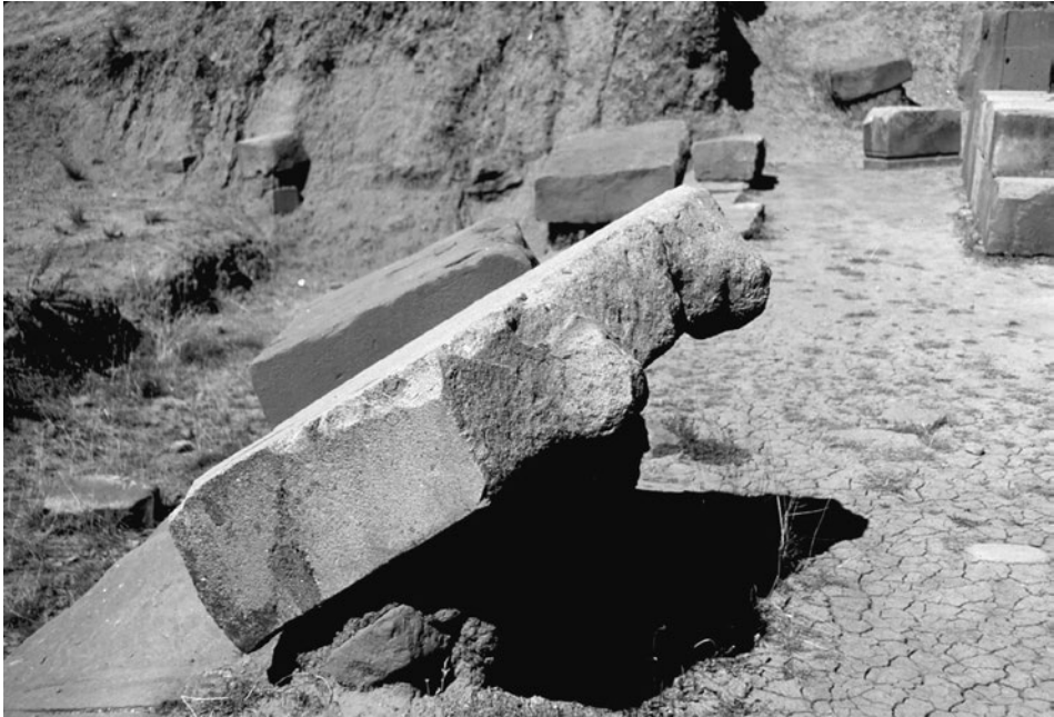
Figura 6.13. Protuberancias para manejar las piedras.
