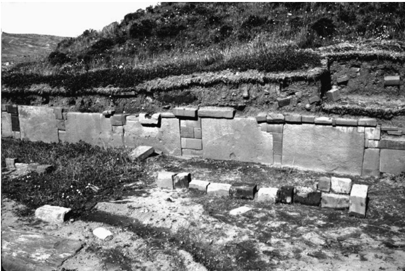
Figura 2.22. Segundo muro con drenaje (Tipo «d»), lado oeste de Akapana.
