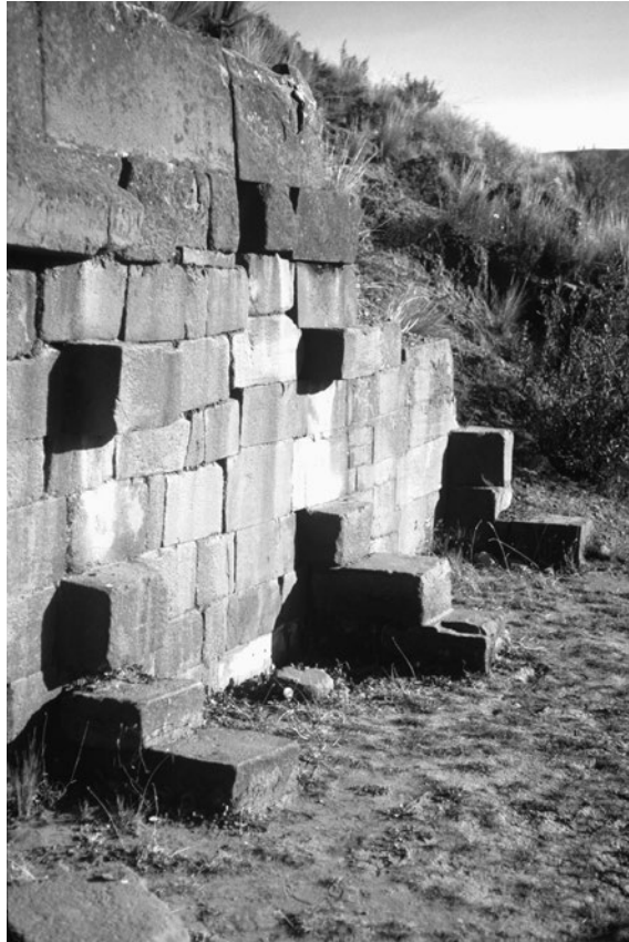
Figura 2.13. Tercer muro con contrafuertes en el lado este de Akapana.
