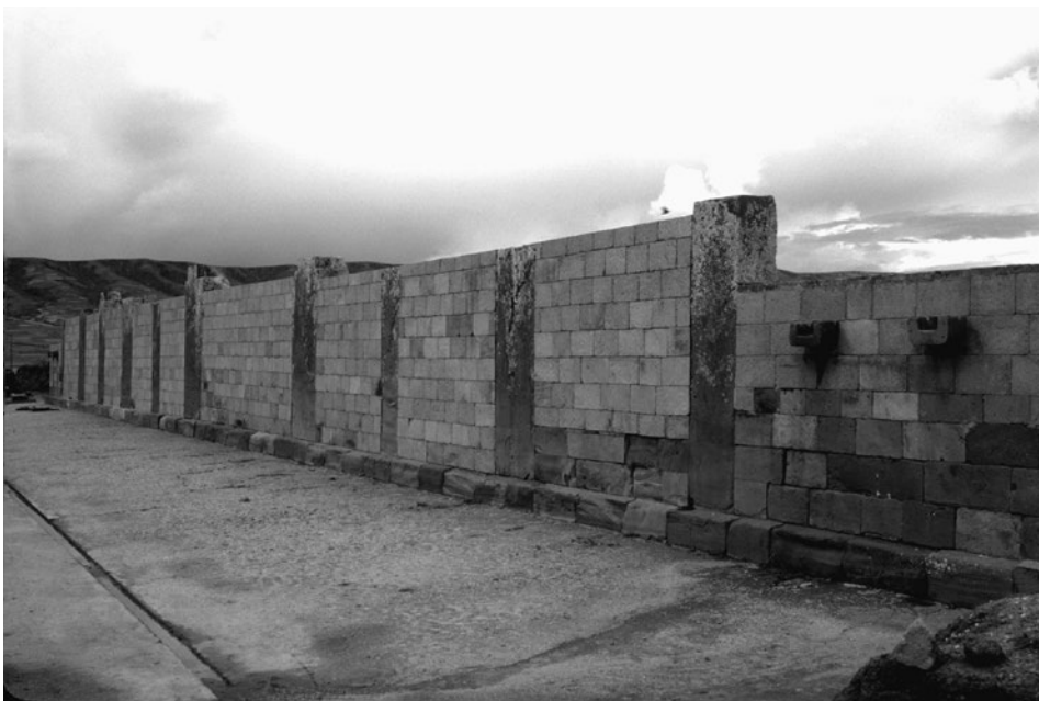
Figura 2.38. Pared Balconera (vista desde el suroeste).
