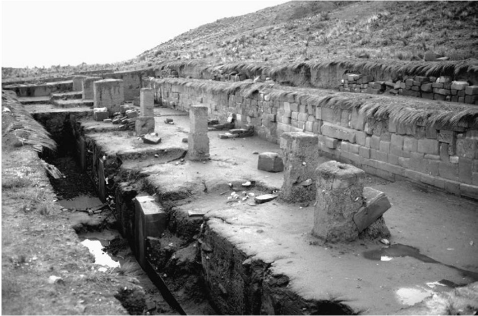
Figura 2.15. Muro base y segundo muro del lado sur de Akapana.
