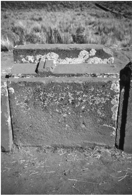
Figura 3.23. Piedra jamba con moldura escalonada.
