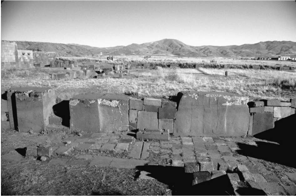
Figura 2.41. Mampostería en el muro norte.
