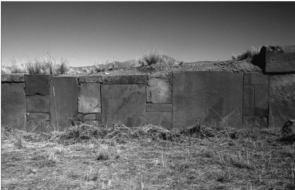
Figura 2.40. Mampostería en el muro este de Putuni.
