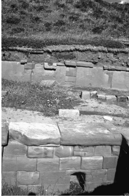
Figura 2.21. Muro base con salida de canal (Tipo «e») y segundo muro, en el lado oeste de Akapana.
