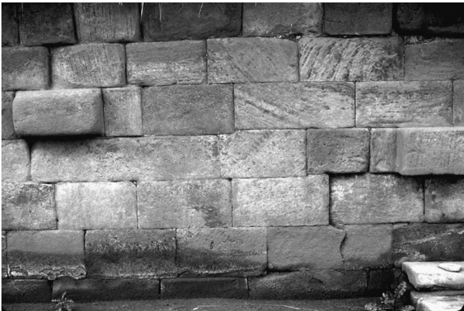
Figura 2.18. Mampostería de aparejo casi regular del segundo muro del lado sur de Akapana.
