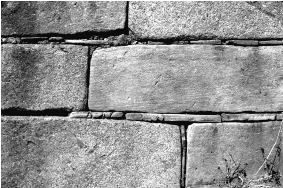
Figura 2.70. Mampostería acuñada de piedra tallada en Chavín de Huántar.
