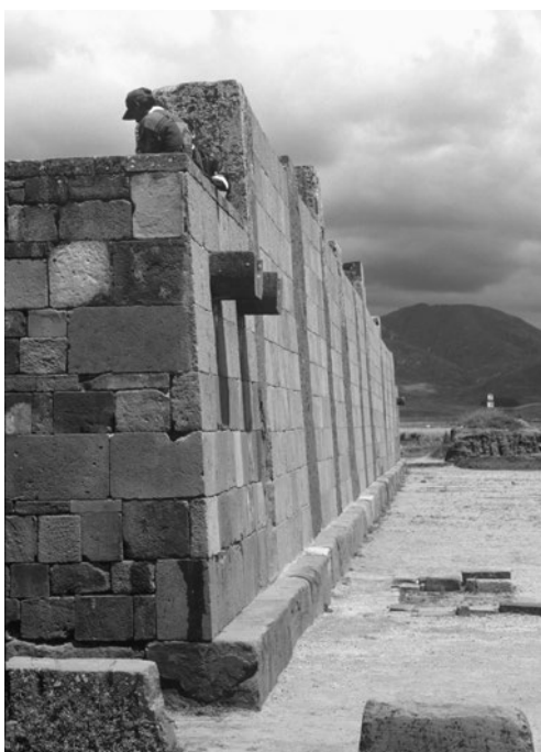
Figura 6.19. Bloques de arenisca usados como cimientos bajo la Pared Balconera.
