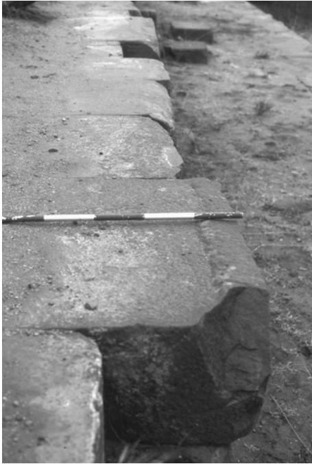
Figura 6.10. Protuberancias residuales en el muro del segundo escalón que sugieren un engastado in situ.
