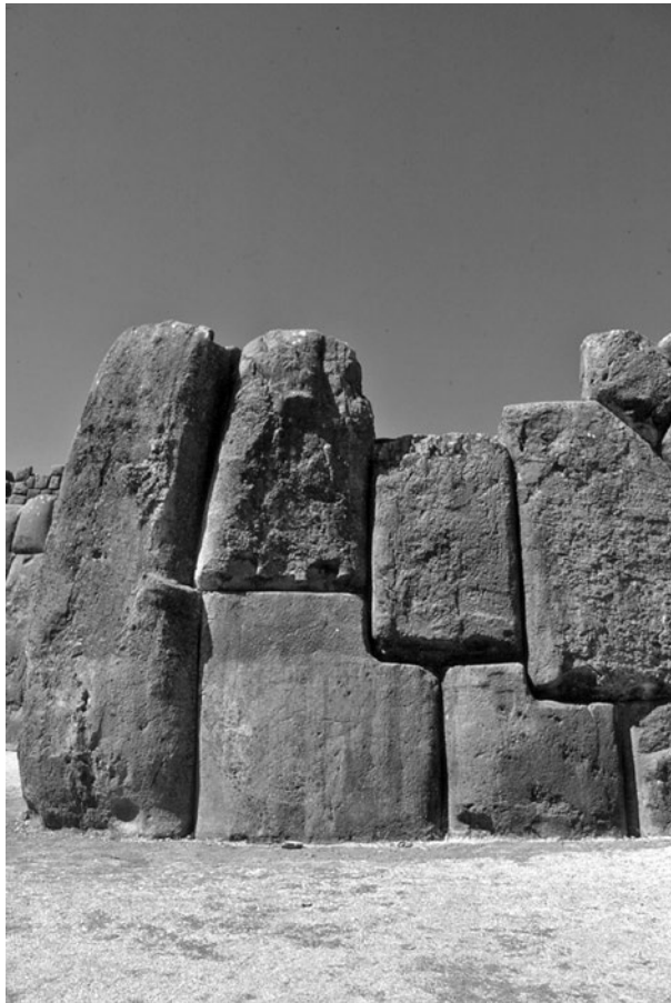
Figura C.2. Juntas con forma de L en Sacsayhuamán.
