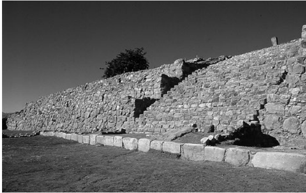
La fachada restaurada, 2003.
