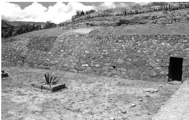
El muro de contención de la plataforma.
