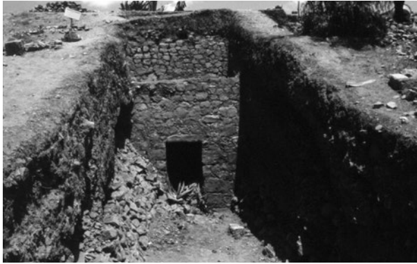
El muro de contención y la entrada de la galería escalonada.
