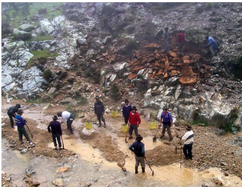
Figura 2. «Acopiando arena y grava para las obras de rehabilitación de las amunas en Tupicocha» como una parte del trabajo comunal para el mantenimiento de las amunas (Apaza, Arroyo & Alencastre, 2006, p. 80).
