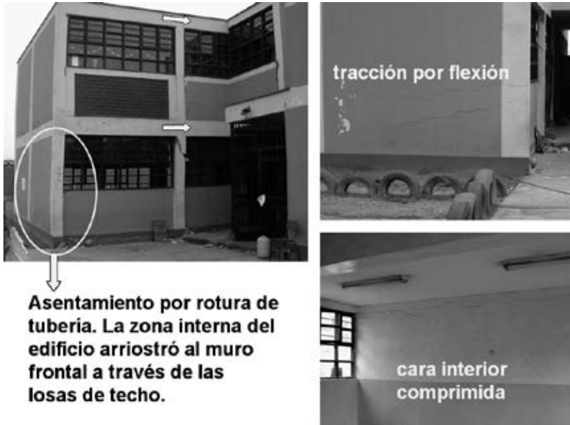
Fig. 7.92. Asentamiento diferencial.
