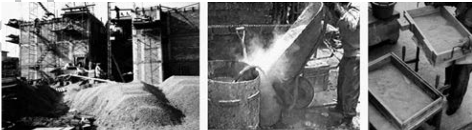
Fig. 4.25. Contaminación de la arena, exceso de polvo y tamizado de la arena.
