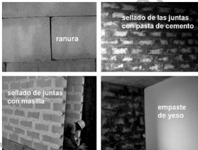
Fig. 4.91. Sellado de juntas y empaste del muro.
