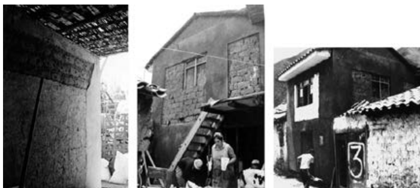
Fig. 8.45. Limpieza, humedecimiento, pañeteo y tarrajeo con mortero cemento-arena fina 1:5 de la zona enmallada.
