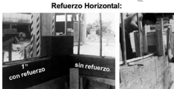
Fig. 8.65. Refuerzo horizontal y abertura en la tapa del molde.
