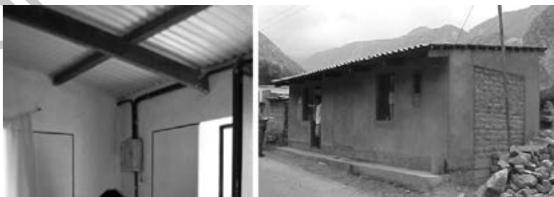
Fig. 8.58. Instalaciones eléctricas y vivienda terminada.
