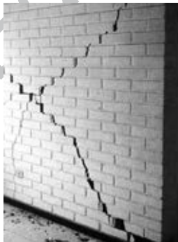
Fig. 7.48. Agrietamiento diagonal y refuerzo horizontal mínimo.
