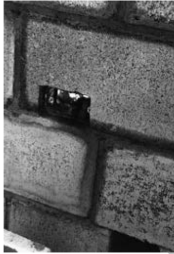
Fig. 4.85. Conducto en la celda.
