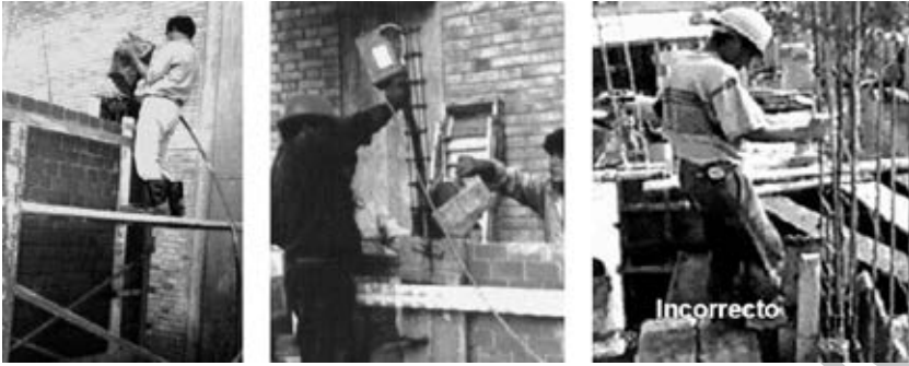
Fig. 4.44. Vaciado y compactación del concreto de columnas.
