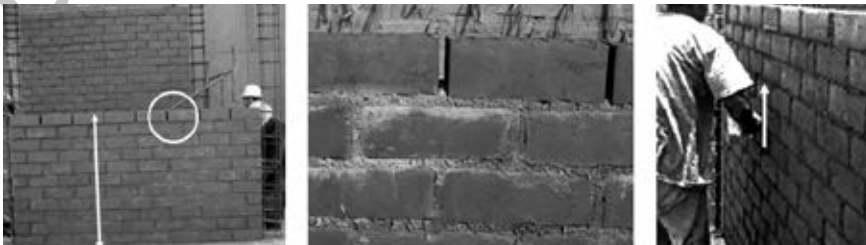
Fig. 4.32. Término de la primera jornada y limpieza del muro.
