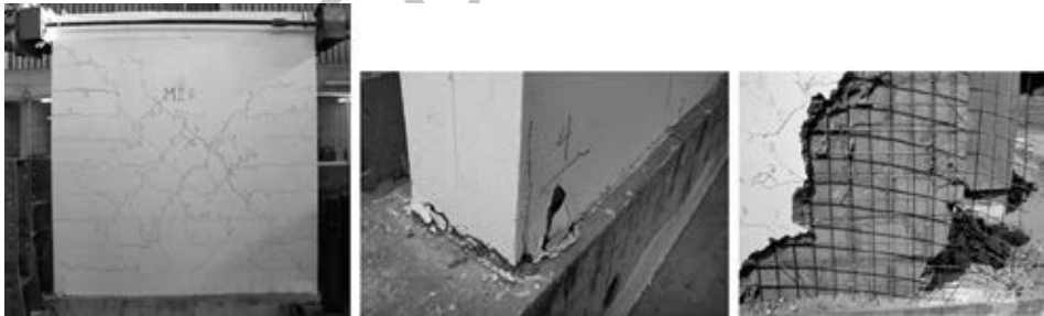
Fig. 5.63. Muro armado reparado post ensayo.
