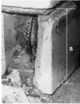
Fig. 7.56. Pandeo extrema en barra de poco diámetro.
