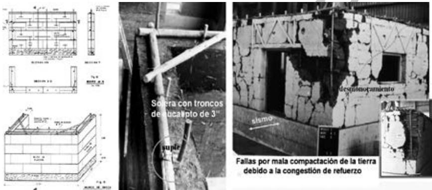
Fig. 8.63. Tapial con refuerzo excesivo.
