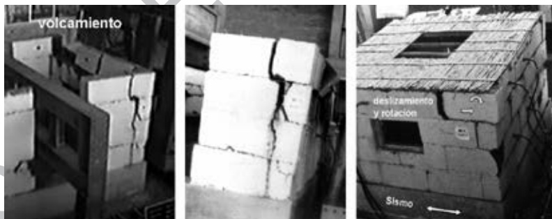
Fig. 8.34. Fallas en el tapial.
