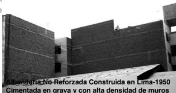
Fig. 5.1. Edificio antiguo en Lima.
