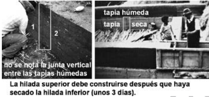
Fig. 8.27. Juntas verticales entre tapias.
