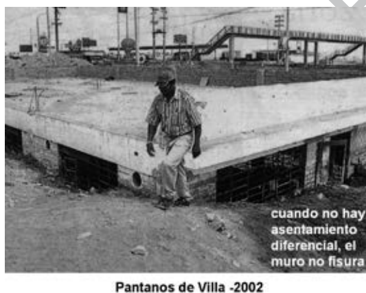
Fig. 4.12. Hundimiento en humedal.
