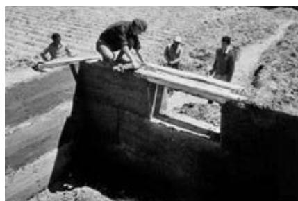
Dinteles de madera tallada o troncos, asentados con barro en un rebajo de la tapia
