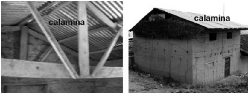
Fig. 8.9. Techado en la Sierra, cobertura de calamina.
