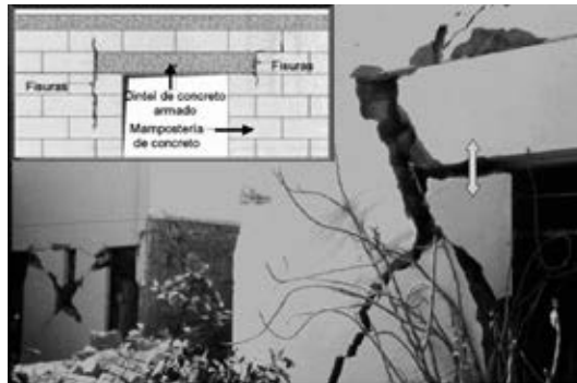
Dinteles peraltados discontinuos. Chimbote, 1970.
