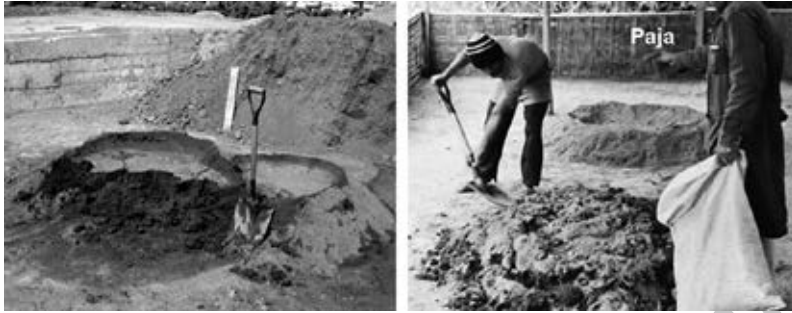
Fig. 8.15. Formación de barro y paja agregada.
