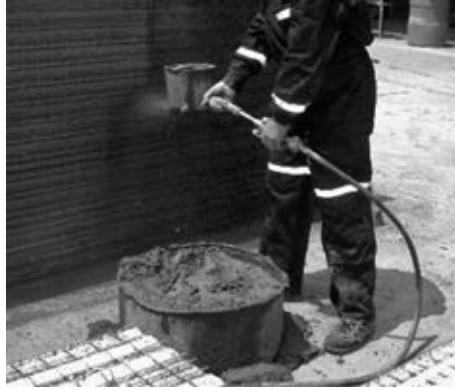
Fig. 5.66. Lanzador hidroneumático de mortero.
