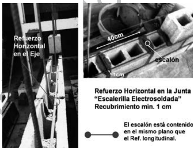
Fig. 1.18. Refuerzo en la albañilería armada.
