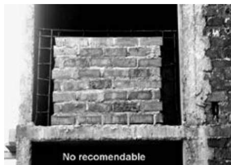
Fig. 7.76. Disposición de refuerzo no recomendable.
