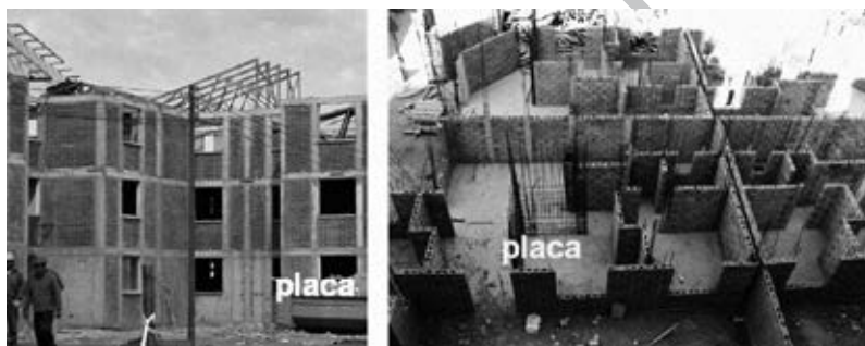
Fig. 7.22. Edificios de albañilería con placas adicionales.
