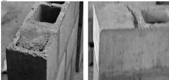
Fig. 3.7. Relleno en esquinas de unidades huecas.
