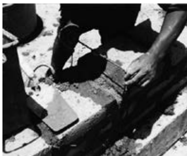
Fig. 8.21. Instalación de conectores de malla.
