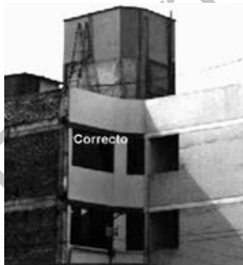
Fig. 6.13. Tanque con apoyo continuo.
