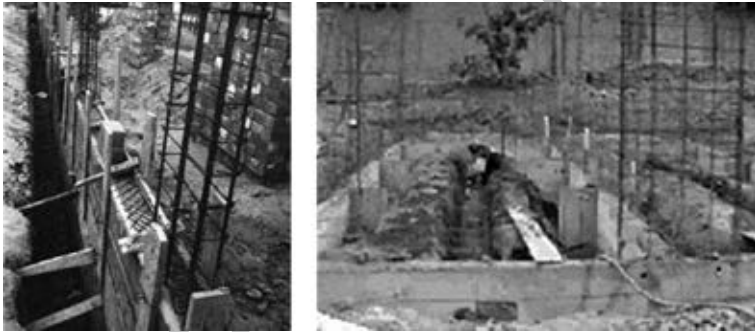
Fig. 4.14. Sobrecimiento. Nótese el rayado de la superficie superior.
