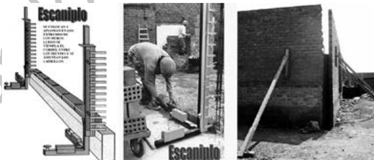
Fig. 4.36. Escaniplo y desaplomo de una pared muy esbelta.
