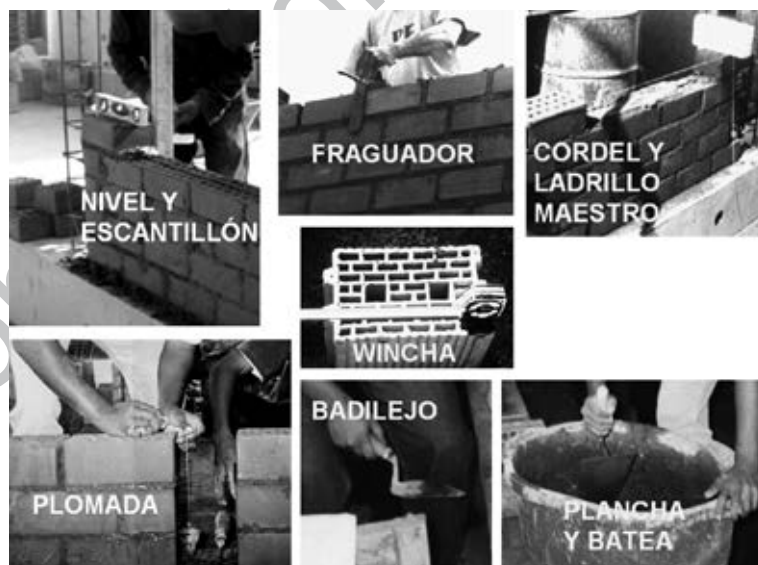
Fig. 8.19. Herramientas para la construcción de los muros.
