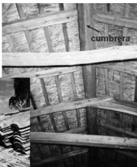
Fig. 8.8. Techado en la Sierra, cobertura de tejas artesanales.
