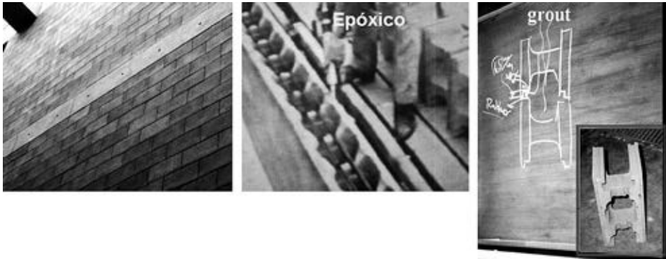
Fig. 4.86. Albañilería de Junta Seca en Japón.
