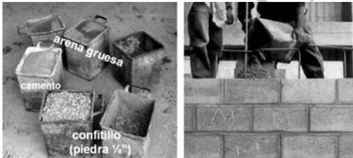
Fig. 2.63. Grout grueso en celdas grandes.
