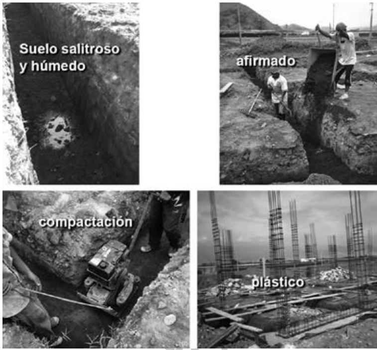
Fig. 4.20. Impermeabilización de la cimentación en suelo húmedo.
