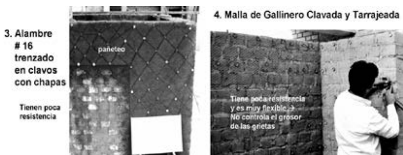
Fig. 8.38. Refuerzo con malla de alambre #16 y de gallinero.
