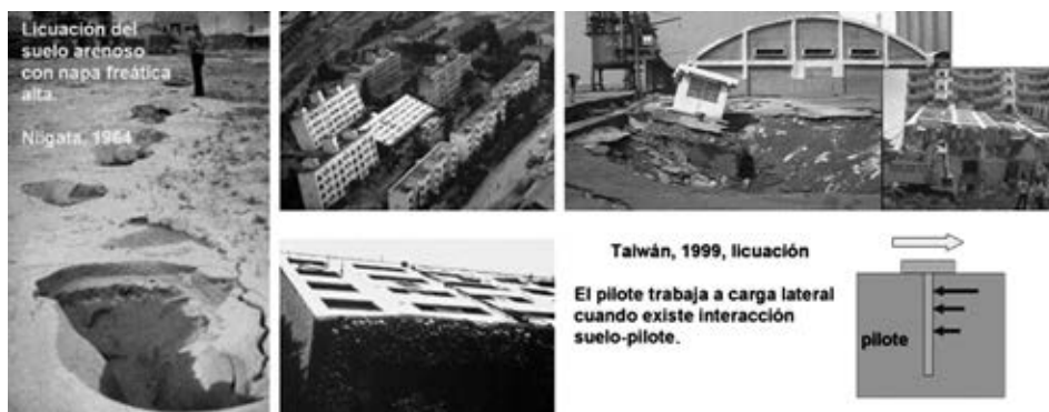
Fig. 4.11. Licuación y pilotes.
