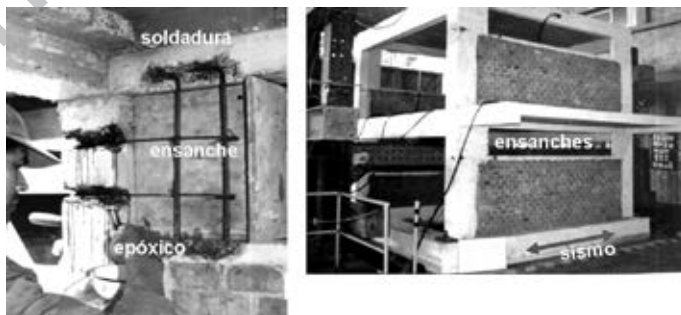
Fig. 5.32. Ensanches en columnas cortas existentes.
