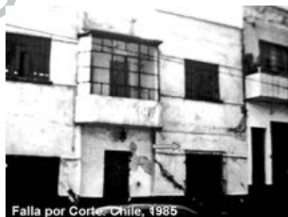
Fig. 5.5. Falla por corte.
