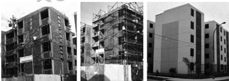
Fig. 4.53. Acabado de los muros.
