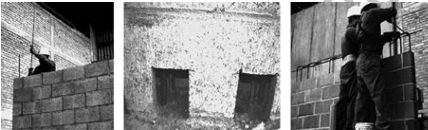
Fig. 4.72. Insertado de barra vertical, traslape y fijación a barra horizontal temporal.
