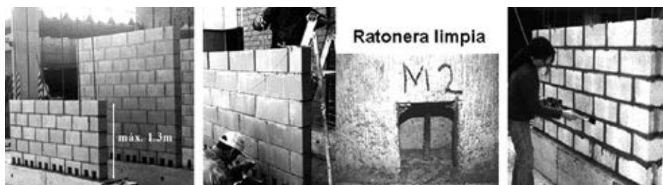
Fig. 4.66. Jornadas de trabajo, limpieza interna de celdas y curado de juntas.
