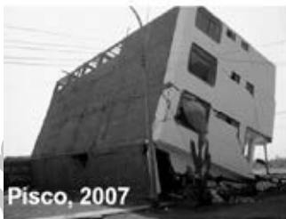
Fig. 5.13. Escasa densidad de muros.
