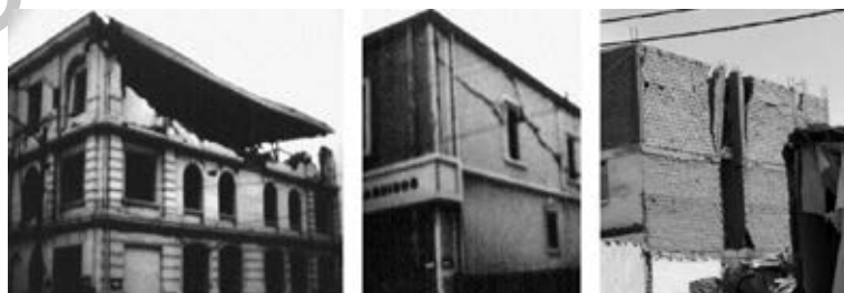
Fig. 7.72. Ausencia de soleras en diafragmas flexibles.
