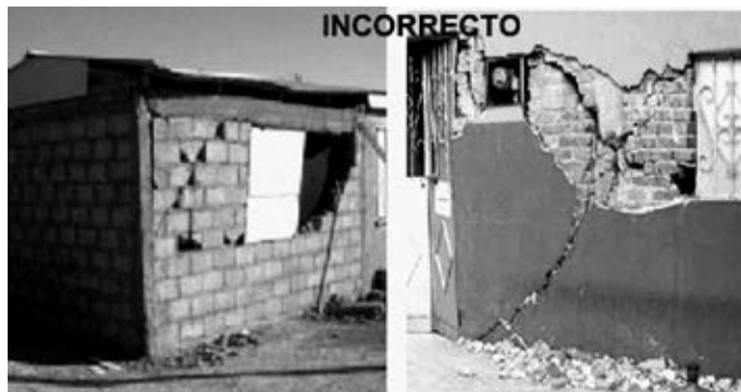
Fig. 1.28. Albañilería no confinada.
