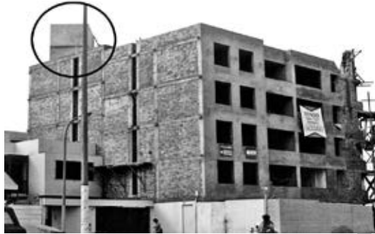
Fig. 6.10. Tanque de agua en posición excéntrica.
