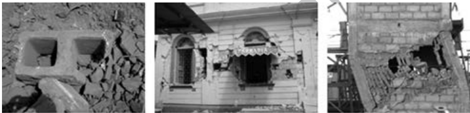
Bloques de concreto vacíos. Estas unidades fueron creadas para ser usadas en la construcción de la Albañilería Armada rellena con grout.
