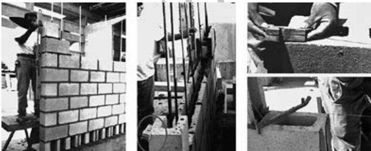
Fig. 4.65. Asentado de bloques y dispositivos para fijar el cordel.
