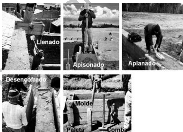
Fig. 8.26. Construcción de una tapia.
