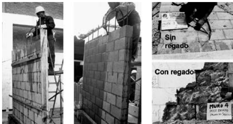
Fig. 4.77. Caso de bloques de concreto vibrado. Regado interno antes del vaciado y antes de encofrar las ratoneras (izquierda), regado externo después del vaciado (centro) y diferencia en la adherencia grout-bloque con y sin tratamiento de regado (derecha).
