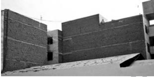
Fig. 1.16. Edificio analizado por Cestti.
