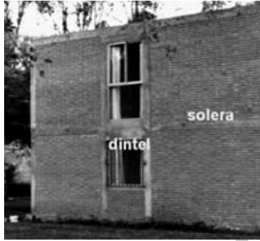
Fig. 1.32. Dintel y solera.
