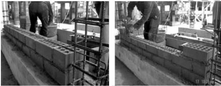
Fig. 4.31. Instalación del refuerzo horizontal y asentado de la hilada inmediata superior.
