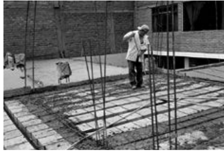
Fig. 6.5. Losa aligerada unidireccional.
