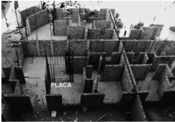
Fig. 1.12. Edificio de albañilería con placa adicional.
