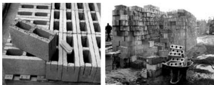
Fig. 4.61. Limpieza, y regado solo para bloques de arcilla.
