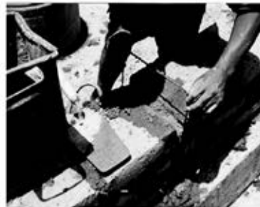
Fig. 8.56. Adobe reforzado con malla electrosoldada y conector.
