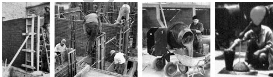
Fig. 4.43. Encofrados y preparación del concreto.
