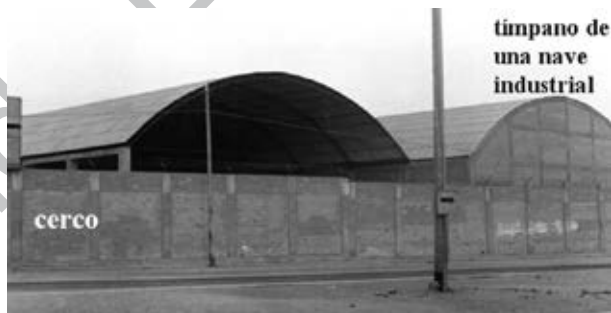
Fig. 7.1. Muros no portantes.
