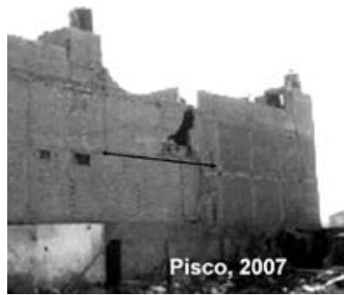
Fig. 5.12. Columnas muy espaciadas.
