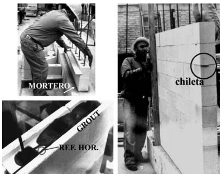
Fig. 4.88. Apilamiento de bloques.
