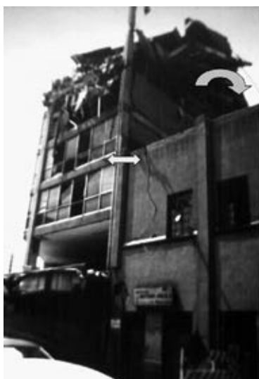
Fig. 5.8. Ausencia de junta sísmica.
