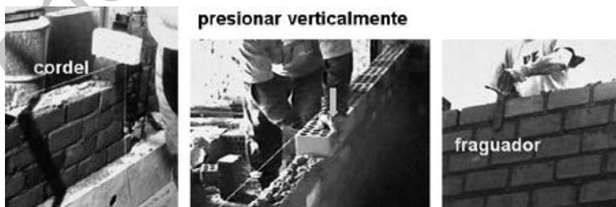
Fig. 4.30. Uso del cordel y del fraguador en el asentado de los ladrillos intermedios.
