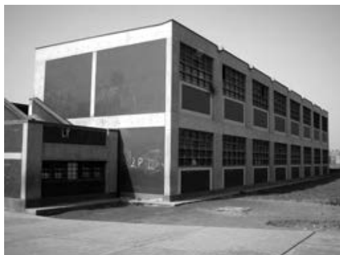
Fig. 6.18. Pisco, sin daños.
