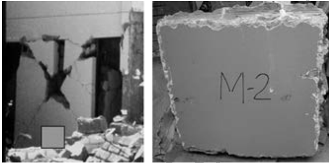
Fig. 3.8. Zona de extracción de muretes.
