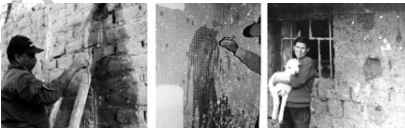
Fig. 8.44. Instalación del conector (alambre #8) y taponado de la perforación con mortero 1:5 (izq.). Instalación de la malla, clavado y engrape del conector (der.).
