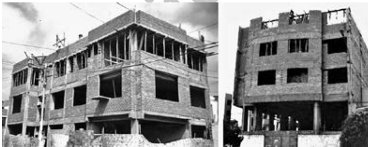
Fig. 5.27. Edificios con piso blando.
