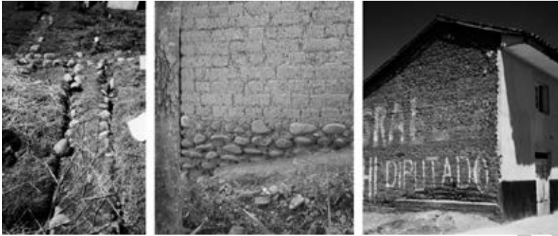
Fig. 8.4. Cimentación y sobrecimiento de pirca y de concreto (derecha).
