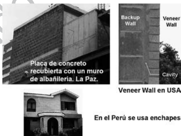
Fig. 1.25. Cobertura de muros portantes.
