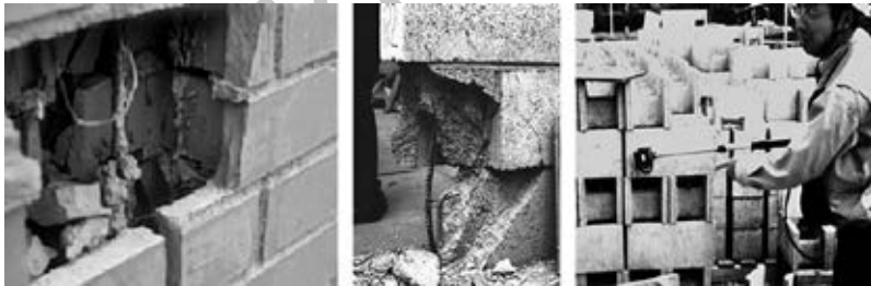
Fig. 4.79. Cangrejeras y equipo de ultrasonido (en Japón).
