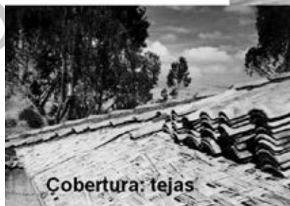
Fig. 8.8. Techado en la Sierra, cobertura de tejas artesanales.
