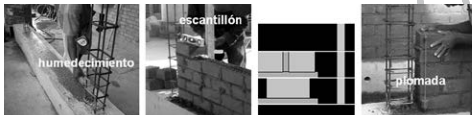
Fig. 4.29. Humedecimiento de la base de concreto y asentado de ladrillos maestros.
