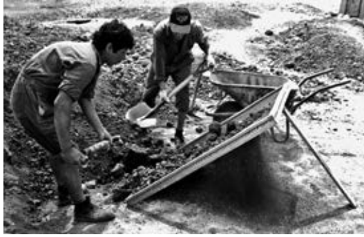
Fig. 8.13. Tamizado del suelo.
