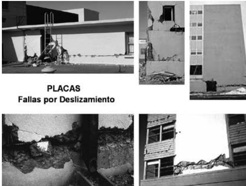
Fig. 7.6. Falla por cizalle en muros de concreto armado.
