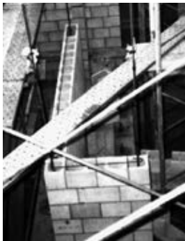
Fig. 7.47. Refuerzo horizontal en un muro armado.
