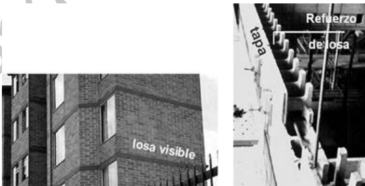
Fig. 4.73. Bloques recortados para ocultar la losa de techo.
