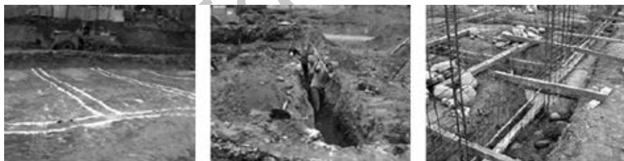
Fig. 4.2. Cimentación de concreto ciclópeo no reforzado.
