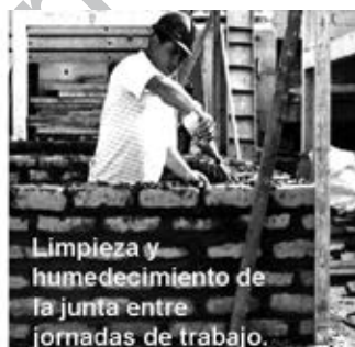
Fig. 8.22. Tratamiento de la junta de construcción entre jornadas de trabajo.
