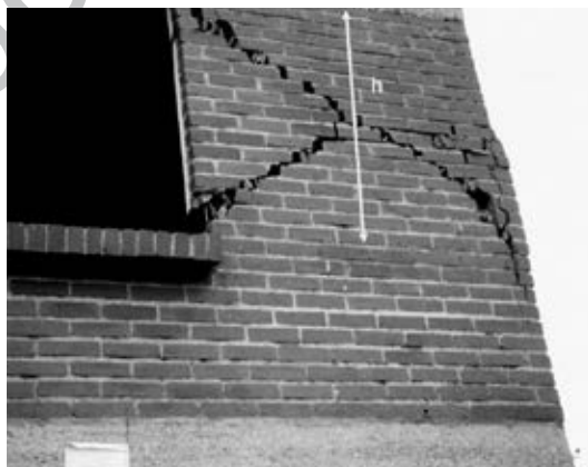
Fig. 6.23. Reducción de la altura efectiva.
