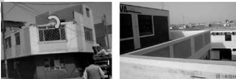
Fig. 5.42. Pisco 2007, parapeto sin arriostar (izquierda) y arriostrado en el tercer piso (derecha).
