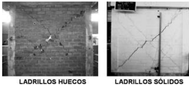
Fig. 2.40. Muros ensayados a carga lateral cíclica.
