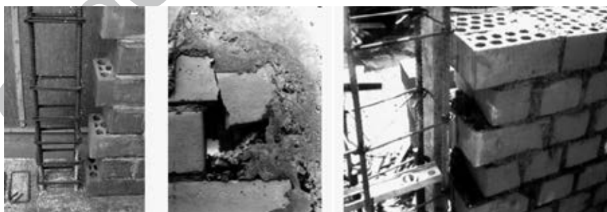
Fig. 4.34. Dientes adecuados, dientes muy largos y desperdicios sobre el diente.
