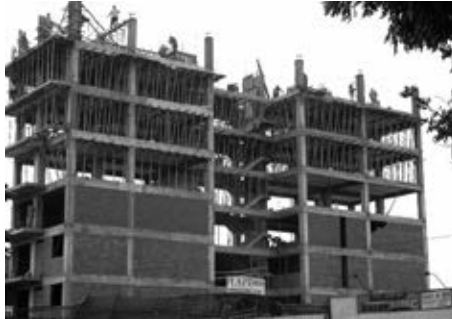
Fig. 5.22. Tabiques de albañilería.
