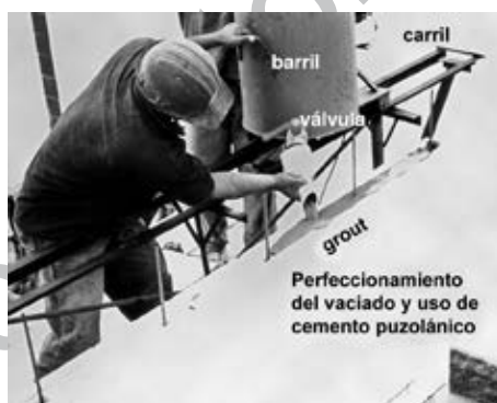
Fig. 4.89. Vaciado del grout.
