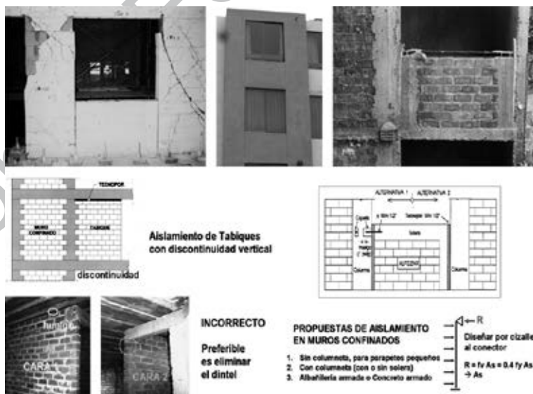
Fig. 6.56. Aislamiento de alféizares y tabiques discontinuos.
