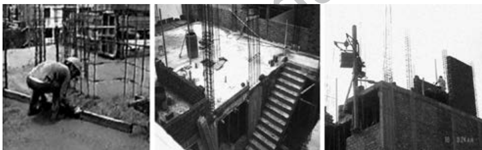
Fig. 4.52. Enrasado del concreto, curado, y construcción de muros del piso superior.
