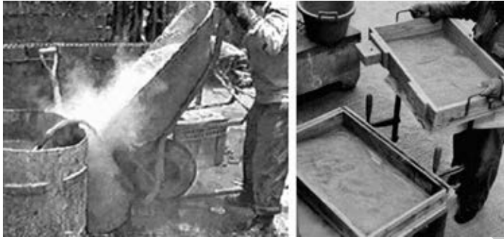
Fig. 2.54. Polvo y tamizado de la arena.
