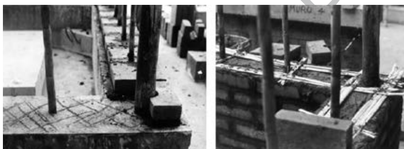
Fig. 8.54. Adobe alveolar reforzado con eucalipto y caña chancada.
