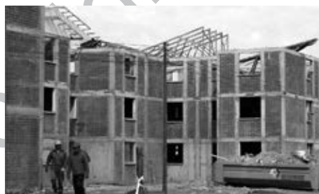
Fig. 7.71. Caso de diafragma flexible en el último nivel.
