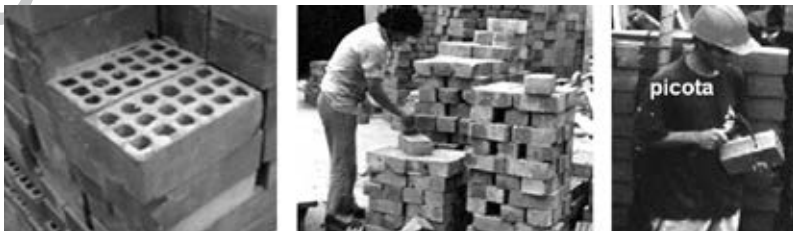
Fig. 4.21. Limpieza y selección de ladrillos. Su recorte puede hacerse con una picota.
