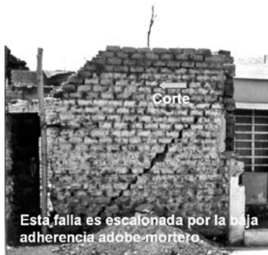
Fig. 8.31. Falla por corte.
