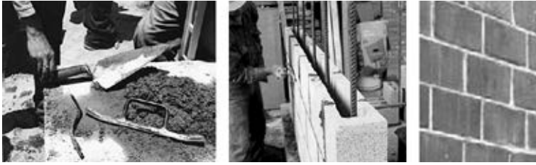
Fig. 4.64. Plancheta, badilejo, bruñador y bruñado de juntas.
