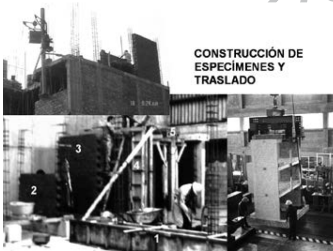
Fig. 5.44. Construcción y traslado.
