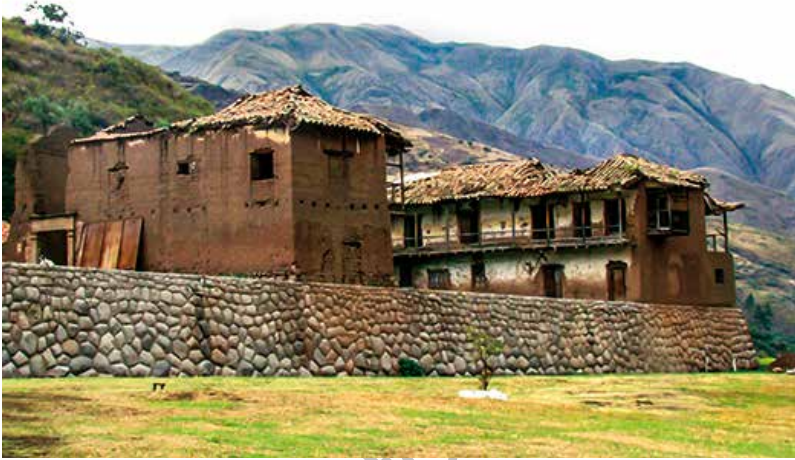
Foto 39. Casa hacienda construida sobre el sitio inca de Tarawasi. Como muchas otras casas haciendas luego de la reforma agraria, esta dejó de ser usada y se fue deteriorando paulatinamente (ver Anrup, 1990). Foto del autor (Limatambo, Cusco, 2009).
