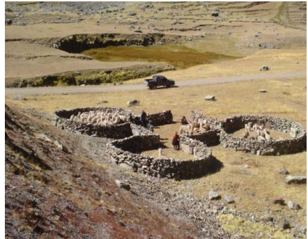
Construcción de corrales
