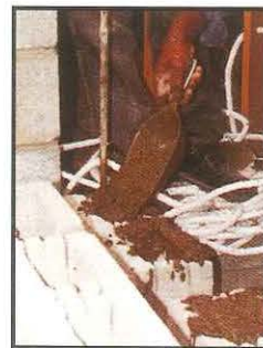
Foto 5 Vaciado del grout
