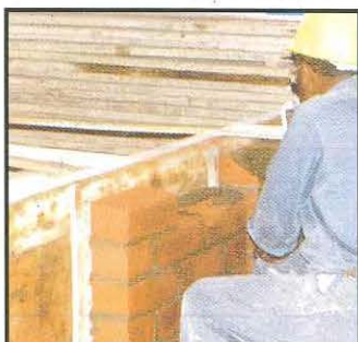
Foto 1 Construcción de muretes
