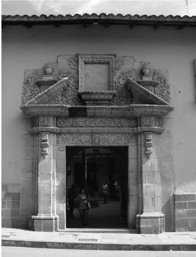
Foto 3. Fachada de piedra de casona colonial
