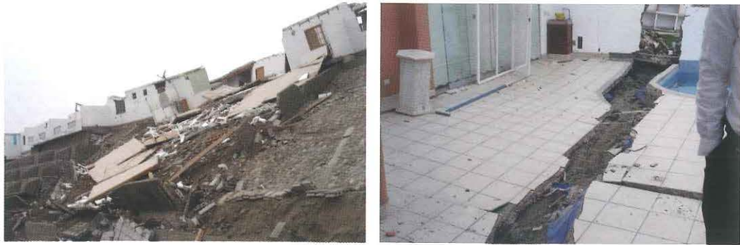
Figura 4. El deslizamiento ocurrido en las playas del sur ocasionó problemas en la cimentación de las edificaciones.
