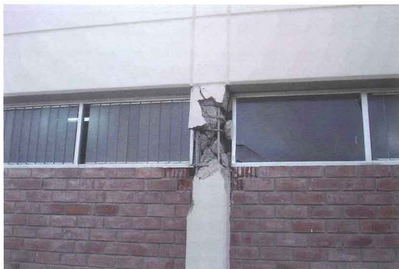
Figura 3. Parapetos de ladrillo que restringen el movimiento de las columnas de la edificación ocasionando el efecto de columna corta.
