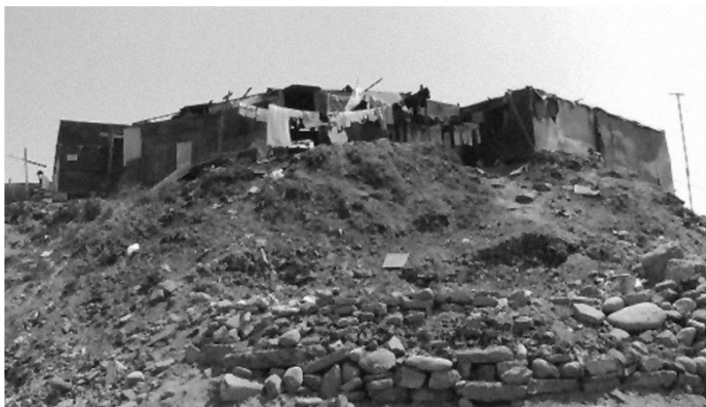
Figura 1. Vista de Cantagallo, tercera zona
