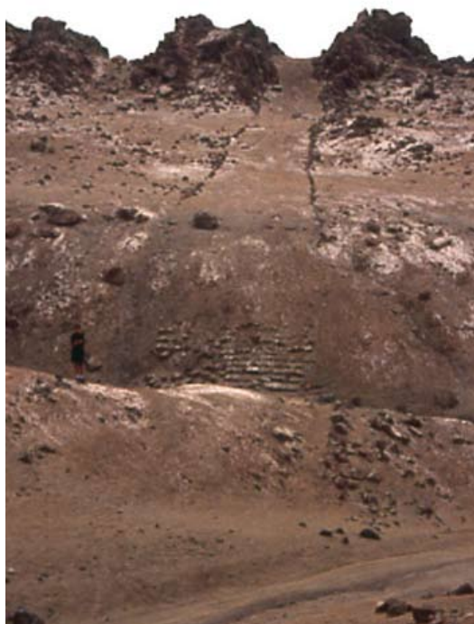
Figura 27: Tramo del camino Inka en Atiquipa cerca de Quebrada de la Vaca, donde se aprecia la construcción de una escalinata para atravesar la depresión de un curso de escorrentía (Canziani 2002).
