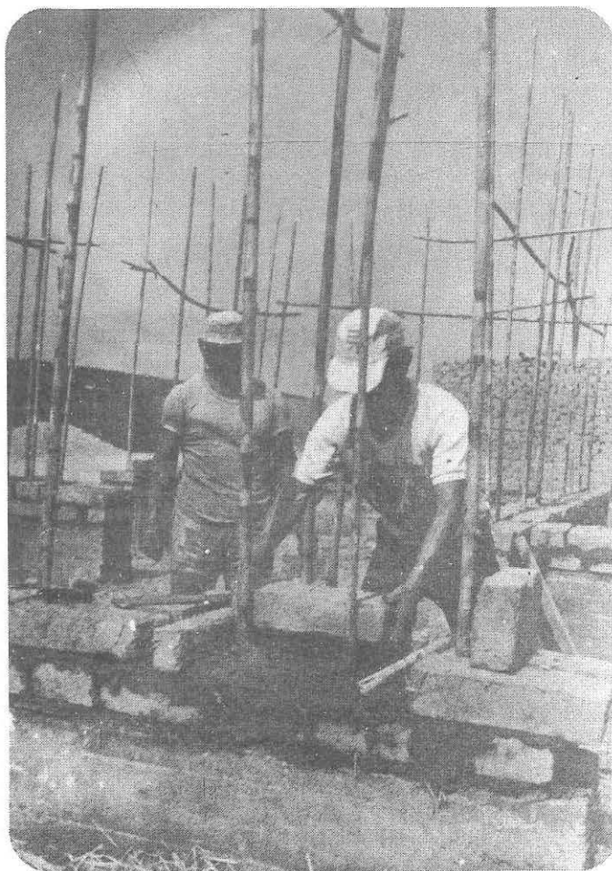
Fig. 8 Construcción de una vivienda con la nueva tecnología en Nuevo Túpac Amaru.
