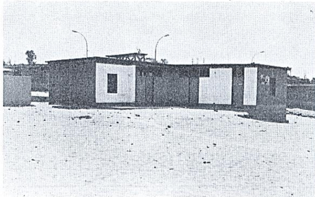
Local del PRONOEI del Grupo Residencial 4A, 6° Sector.
