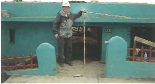
Figura 27.- Tambo de Mora.- Asentamientos de aproximadamente 0.90 m.
