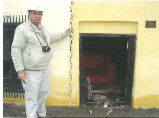
Figura 27.- Tambo de Mora.- Asentamientos de aproximadamente 0.90 m.
