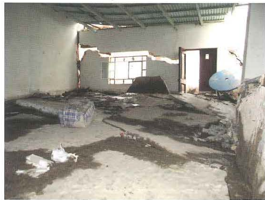
Figura 28.- Tambo de Mora.- (a) Exterior de la vivienda ubicada en Alfonso Ugarte N° 195, con asentamientos de aproximadamente 0.90 m. (b) Interior de la misma vivienda de un piso con techo de calamina. Luego de la demolición de la casa se realizó en el medio de la habitación que se muestra una perforación de 15.45 m con SPT @ 1.00m (el análisis de este esta perforación se encuentra en proceso)
