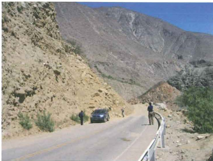
Figura 40.- Fallas de estabilidad de taludes.- Deslizamiento de suelo y roca en la Vía Los Libertadores.
