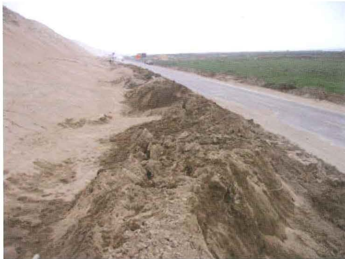
Figura 37.- Fallas de estabilidad de taludes.- Avalancha de suelo en la carretera Panamericana.
