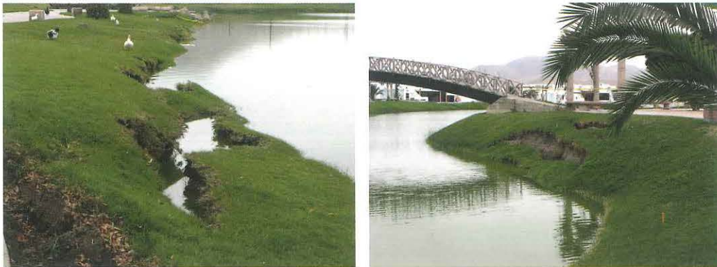
Figura 14.- Las Lagunas de Puerto Viejo.- Desplazamientos en la zona de las lagunas artificiales.
