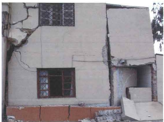
Figura 35.- Malecón de Pisco.- (a) Muro en el malecón fallado por licuación con desplazamiento lateral. (b) Casa (en la zona del malecón) colapsada por licuación el asentamiento de esta casa fue de 0.15 a 0.20 m.
