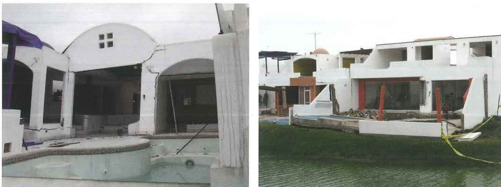
Figura 12.- Las Lagunas de Puerto Viejo. - Colapso de viviendas causadas por la licuación y el desplazamiento lateral.
