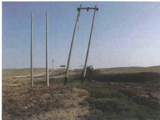
Figura 34.- Ingreso a la ciudad de Pisco.- (a) Postes inclinados al haber fallado la cimentación por licuación (los postes verticales corresponden a una instalación posterior al sismo). (b) Grietas típicas encontradas en esta zona licuada.
