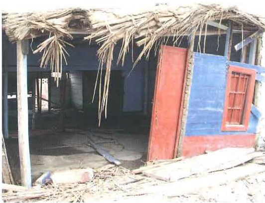
Figura 29.- Tambo de Mora.- (a) Vivienda de madera y techo de esteras con torta de barro hundida por licuación. (b) Estado típico de los pisos de las viviendas en Tambo de Mora luego de la licuación, el centro corresponde aproximadamente al nivel del piso antes de la licuación, las paredes se hundieron 0.80 m
