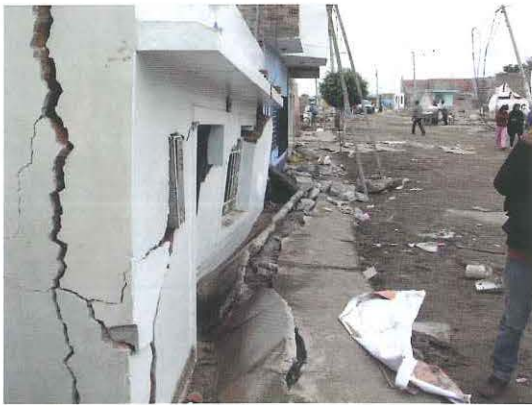
Figura 28.- Tambo de Mora.- (a) Exterior de la vivienda ubicada en Alfonso Ugarte N° 195, con asentamientos de aproximadamente 0.90 m. (b) Interior de la misma vivienda de un piso con techo de calamina. Luego de la demolición de la casa se realizó en el medio de la habitación que se muestra una perforación de 15.45 m con SPT @ 1.00m (el análisis de este esta perforación se encuentra en proceso)
