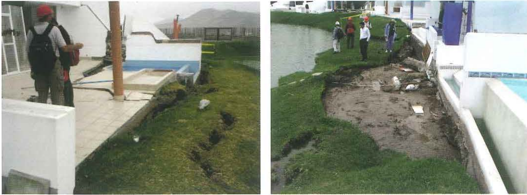
Figura 13.- Las Lagunas de Puerto Viejo.- (a) Desplazamientos laterales y fallas asociadas. (b) Desplazamiento lateral por licuación de 3.90 m
