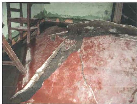
Figura 29.- Tambo de Mora.- (a) Vivienda de madera y techo de esteras con torta de barro hundida por licuación. (b) Estado típico de los pisos de las viviendas en Tambo de Mora luego de la licuación, el centro corresponde aproximadamente al nivel del piso antes de la licuación, las paredes se hundieron 0.80 m
