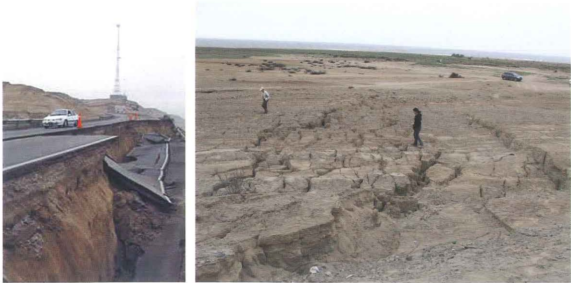
Figura 22.- Desplazamiento lateral en Canchamaná.- (a) Curva de ingreso a la Ciudad de Chíncha Alta: falla en el talud la carretera. (b) Grietas en la zona baja del talud, estas grietas son perpendiculares a la costa y se encuentran en la zona norte de Canchamaná.
