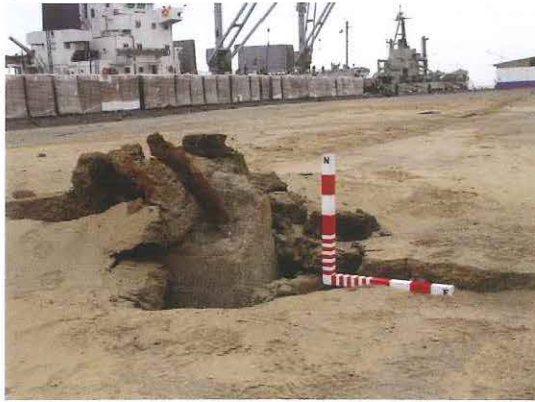
Figura 33.- Terminal Marítimo General San Martín.- La licuación causó en la zona de maniobras del terminal asentamientos que ocasionaron el punzonamiento del pavimento por pilotes enterrados en la zona. En la foto (a) se puede apreciar la arena eyectada por la licuación.
