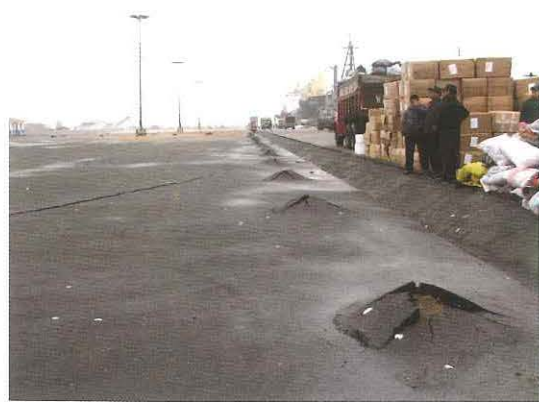
Figura 33.- Terminal Marítimo General San Martín.- La licuación causó en la zona de maniobras del terminal asentamientos que ocasionaron el punzonamiento del pavimento por pilotes enterrados en la zona. En la foto (a) se puede apreciar la arena eyectada por la licuación.
