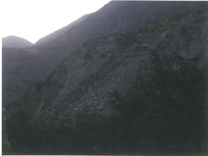
Figura 39.- Fallas de estabilidad de taludes.- Deslizamiento de rocas en talud natural en la Vía Los Libertadores.
