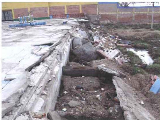
Figura 35.- Malecón de Pisco.- (a) Muro en el malecón fallado por licuación con desplazamiento lateral. (b) Casa (en la zona del malecón) colapsada por licuación el asentamiento de esta casa fue de 0.15 a 0.20 m.
