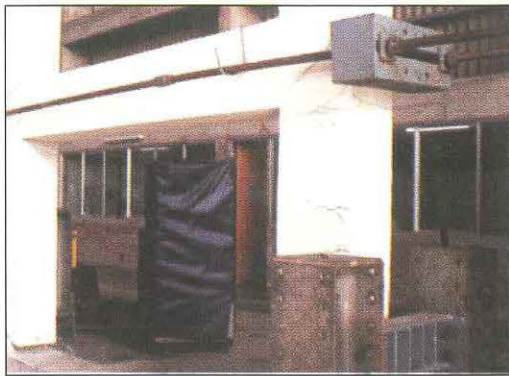
Foto 4. Ensayo Estático sin Drywall.
