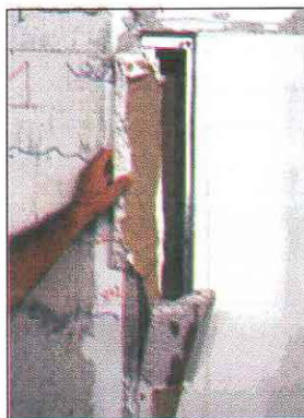
Foto 6. Detalles de la falla por trituración en las placas en las esquinas del tabique.
