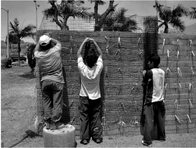
Figura 2. Refuerzo con geomalla en muros de adobe
