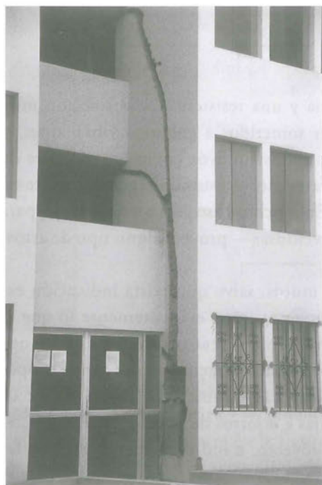
8.13. Muros severamente dañados al haber sido picados para formar canales que alojen a los tubos de las instalaciones eléctricas.
