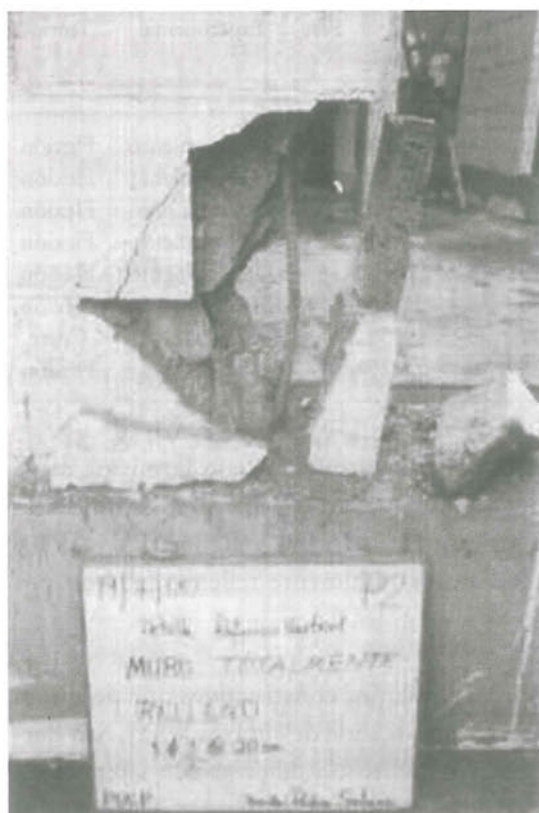
10.50. Trituración del talón, nótese el pando del refuerzo vertical [244].
