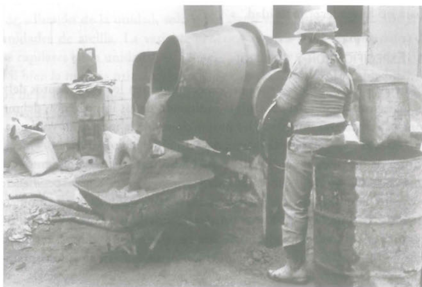
5.19. Trompo para el mezclado del mortero.
