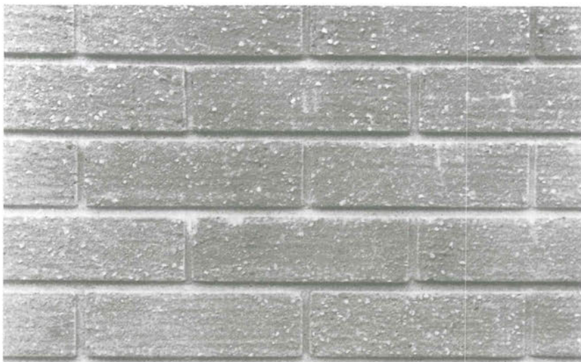
8.3. Albañilería correcta: muro con juntas de 9 a 12 milímetros.
