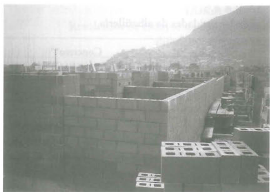
4.29. Construcción de muros con bloques apilables. a) Con bloques estándar; b) enlucido con mortero de cemento, cal, cloruro de calcio, estearato de calcio y fibra de vidrio que provee adhesión a través de la superficie; c) con unidades Keybric-Morandi; d) con bloques Haenner; e) con bloques Apilables; f) con bloques de arcilla
