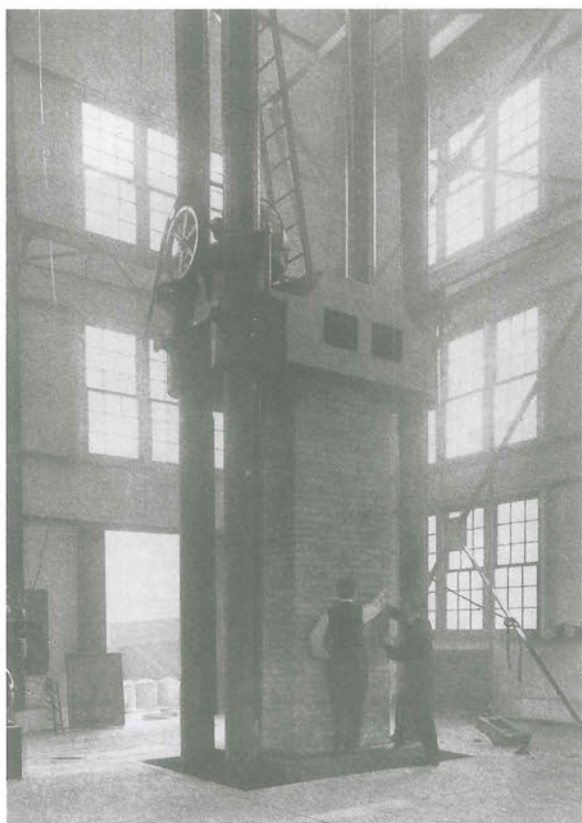
3.13. Ensayo de un muro a escala natural con carga axial de compresión en el laboratorio del Bureau of Standards de los Estados Unidos en el año 1916, utilizando lo que se consideraba «la máquina más poderosa del mundo».
