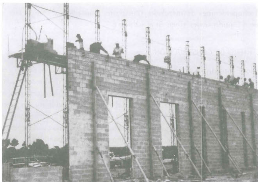
8.12. Muro protegido mediante arriostramiento provisional.
