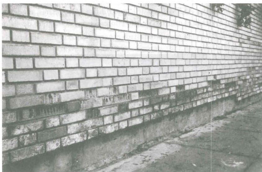
1.5. Graves daños en un muro ocasionados por la eflorescencia. Las unidades tenían un elevado contenido de sales y la construcción de albañilería estaba en contacto con la humedad. Nótese que la destrucción ha ocurrido en la zona baja húmeda.
