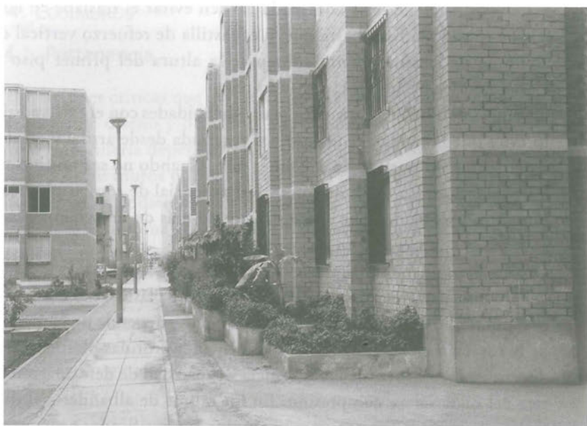
11.14. Conjunto Residencial Limatambo (Lima 1981) Albañilería armada de arcilla ( f'_m = 7 MPa), losas de concreto armado, columna de confinamiento. Notar la concentración de estribos en los extremos y la ausencia de empalmes del refuerzo vertical en el arranque del muro.
