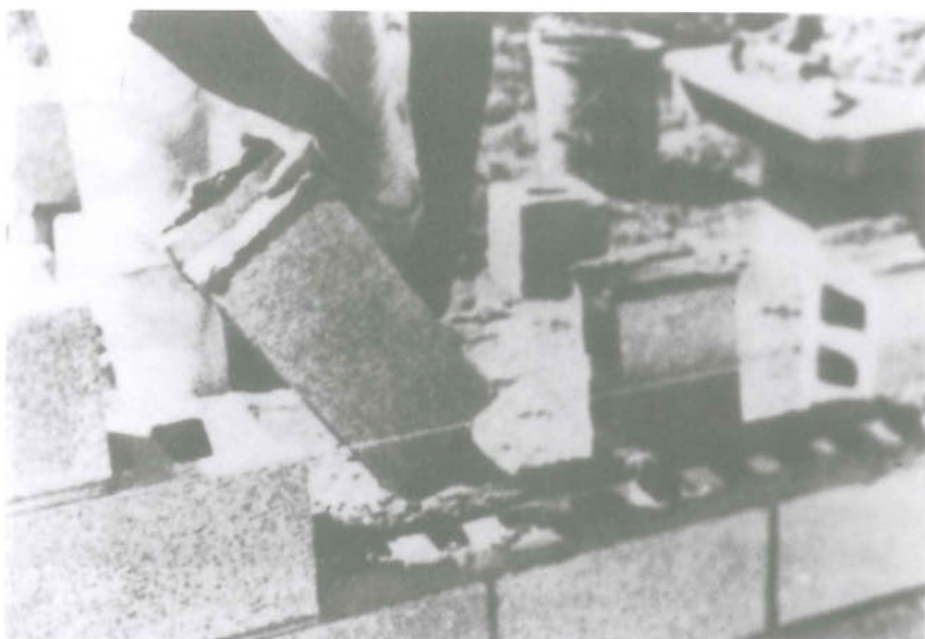
8.8. Asentado de boques: preparación de las caras verticales colocándoles mortero.
