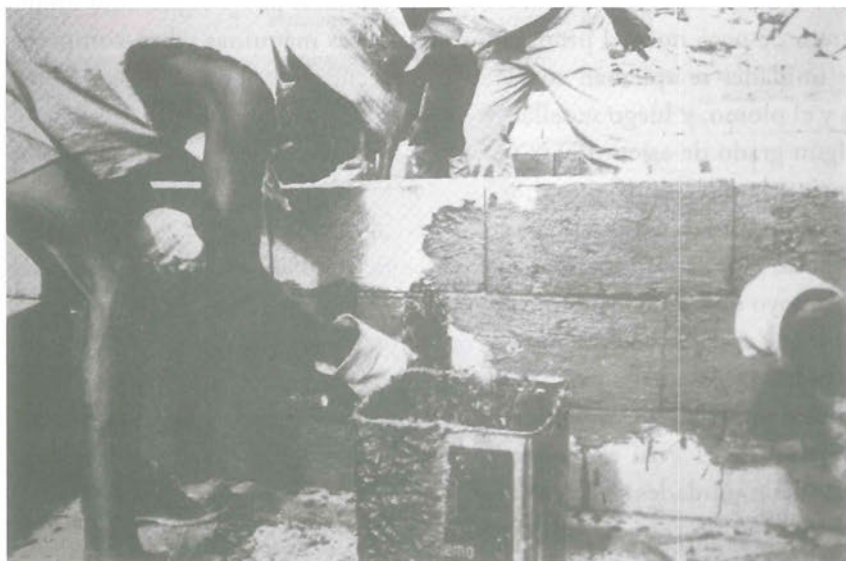
4.8. Construcción de albañilería apilada con bloques semiindustriales.
