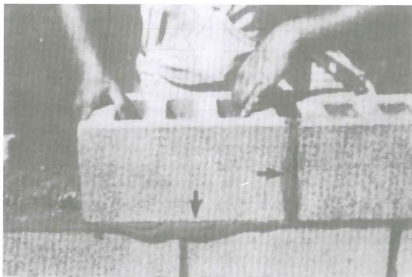
8.9. Asentado de bloques: presión de asentado vertical y horizontal.
