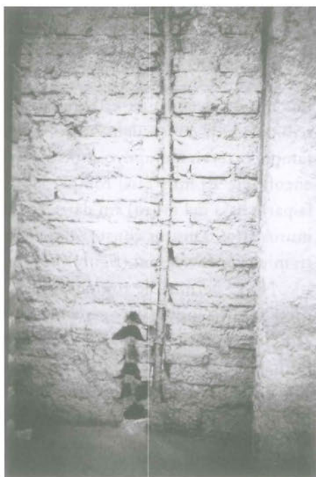
8.13. Muros severamente dañados al haber sido picados para formar canales que alojen a los tubos de las instalaciones eléctricas.
