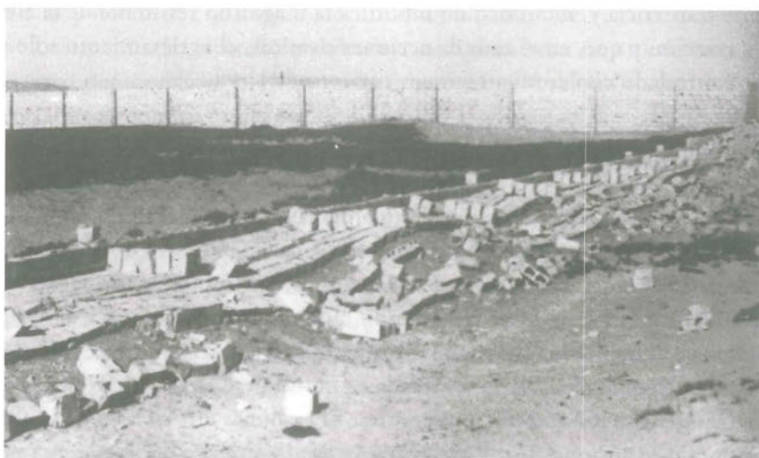
1.11. Chimbote, Perú (1970). Cerco volcado por la acción sísmica perpendicular a su plano como consecuencia de la ausencia de armadura y la poca adhesión mortero-unidad. Nótese que el muro paralelo a la acción sísmica no ha sufrido daño alguno.
