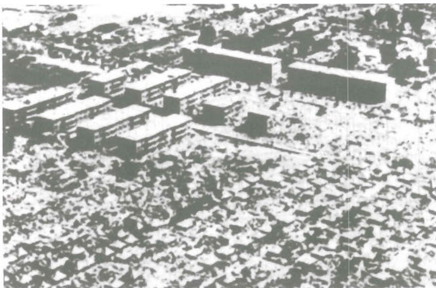
11.4. El Asham (Argelia), 10 de octubre de 1980. M=7,2 . (Foto: V. Bertero)
