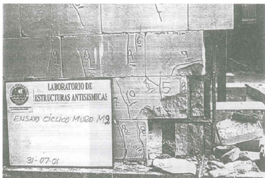
10.31. Estado final del muro para un desplazamiento de 17,35 mm (distorsión angular de 1/138)
