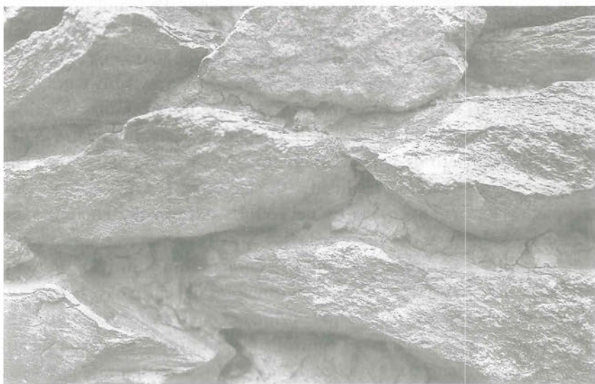
3.1. Ollantaytambo. Cusco, Perú (siglo XIV). a) Esquema de las edificaciones en las laderas. Los muros son de piedra; han sido asentados con barro y recubiertos luego con enlucido de barro. b) Detalle de la albañilería.
