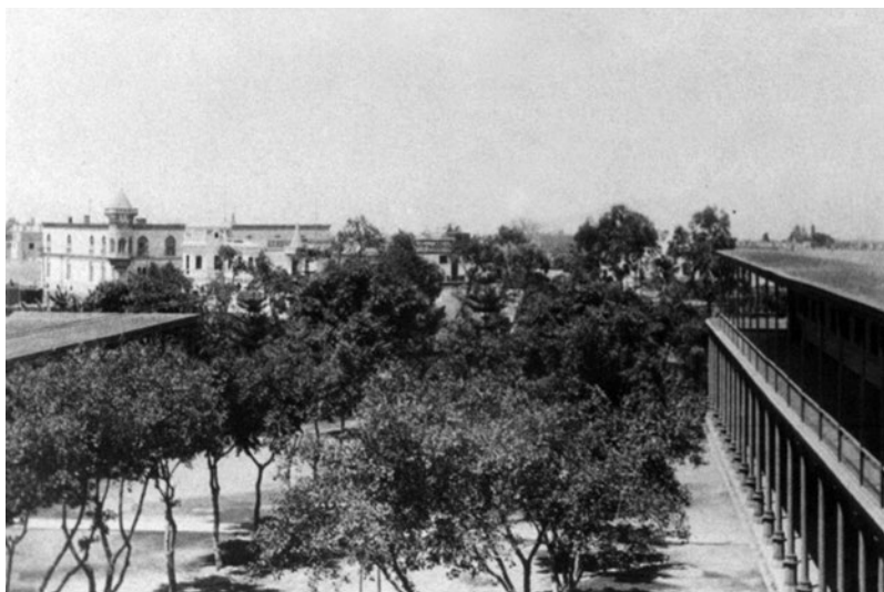
Vista aérea del patio del primer local de la Universidad Católica, ubicado en la Plaza Francia.
