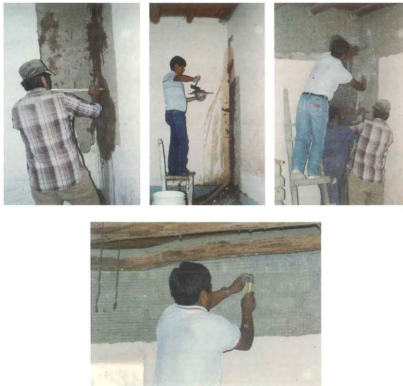
Fig. 5.- Casa de Guadalupe: perforaciones en el muro en una franja vertical (arriba izq.), taponado con mortero (arriba centro); colocación de la malla electrosoldada en una esquina (arriba der.) y clavado de malla (abajo, der).
