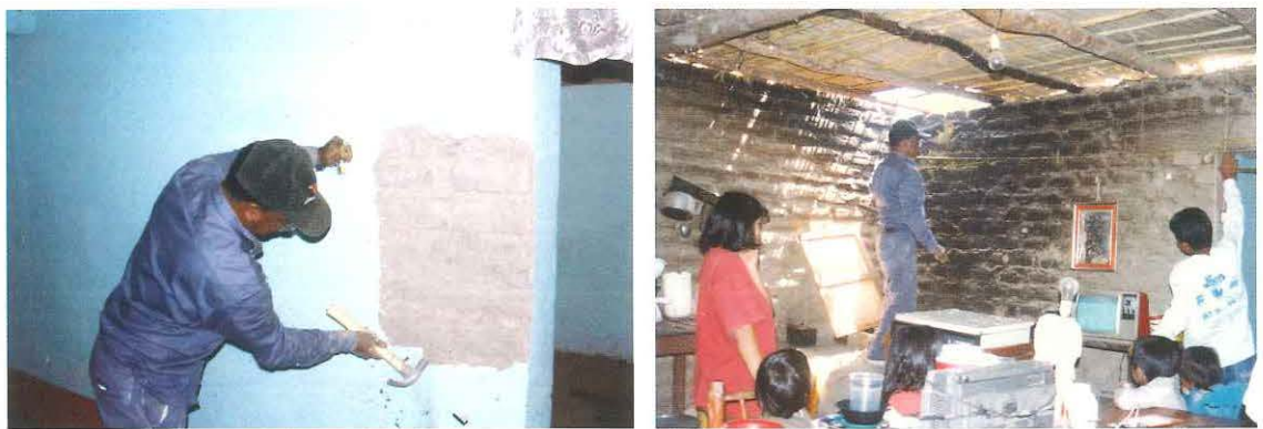
Fig. 6.- Casa de Pachacutec: vista lateral (arriba, izq.), trazado de franja vertical (arriba, der.), remoción de enlucido existente (abajo, izq.), y trazado de franja horizontal (abajo, der.).
