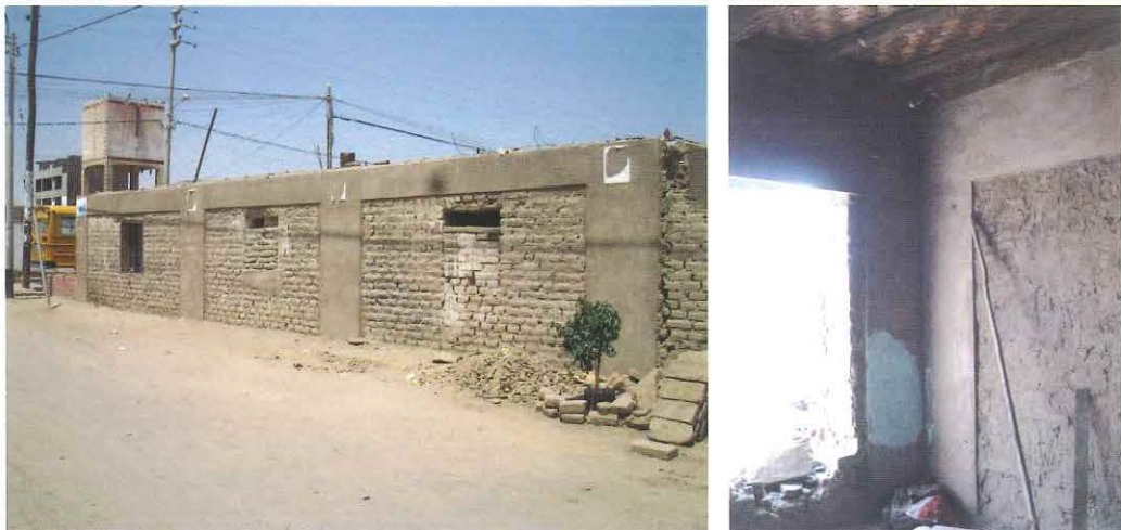
Fig. 8.- Casa reforzada en Guadalupe sin daños
