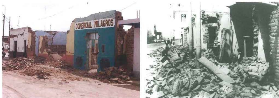
Fig. 1.- Destrucción de viviendas de adobe no reforzado en el Perú: sismo de 1970 (izquierda) y de 1996 (derecha).
