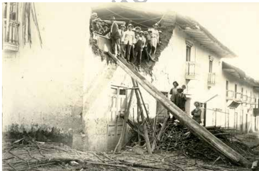
Destrucciones y reconstrucciones de arquitectura tradicional en el centro histórico de Cajamarca, en fotografías de archivo. Fuente: Archivo Regional de Cajamarca, sin números, sin fechas.
