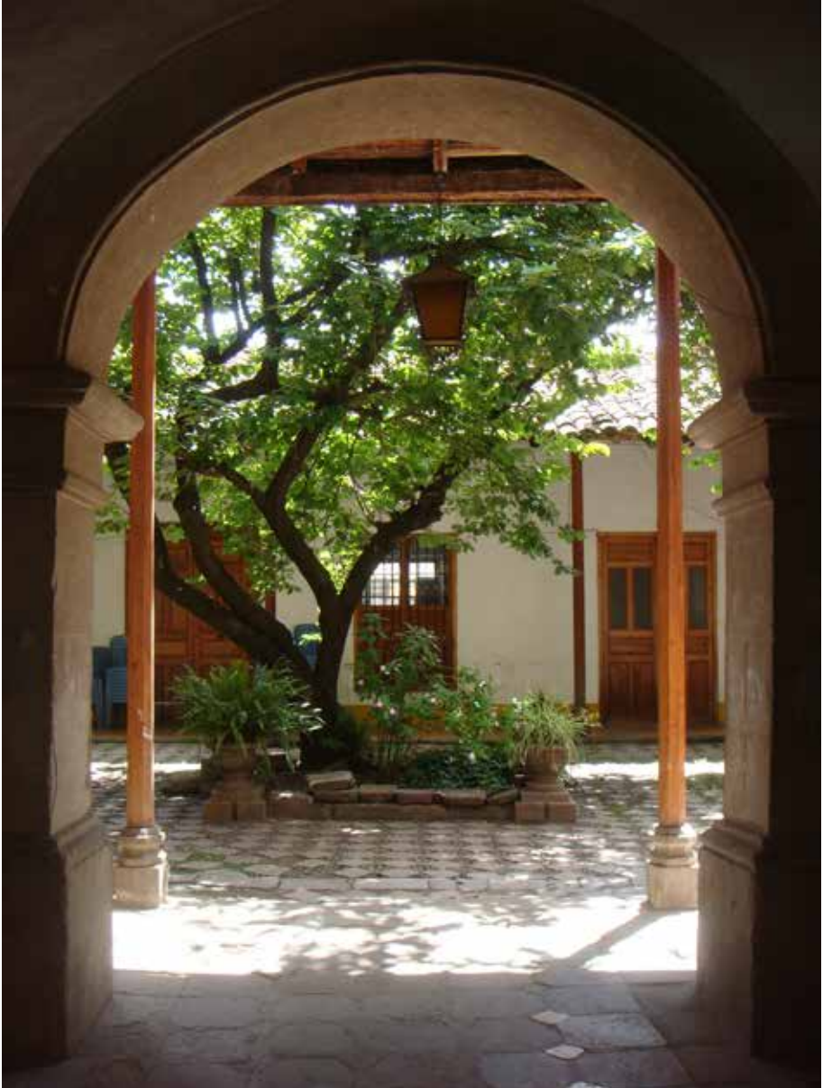
Vista del patio principal de la Casa Alva desde el zaguán. Fotografía de A. Scaletti (2011).
