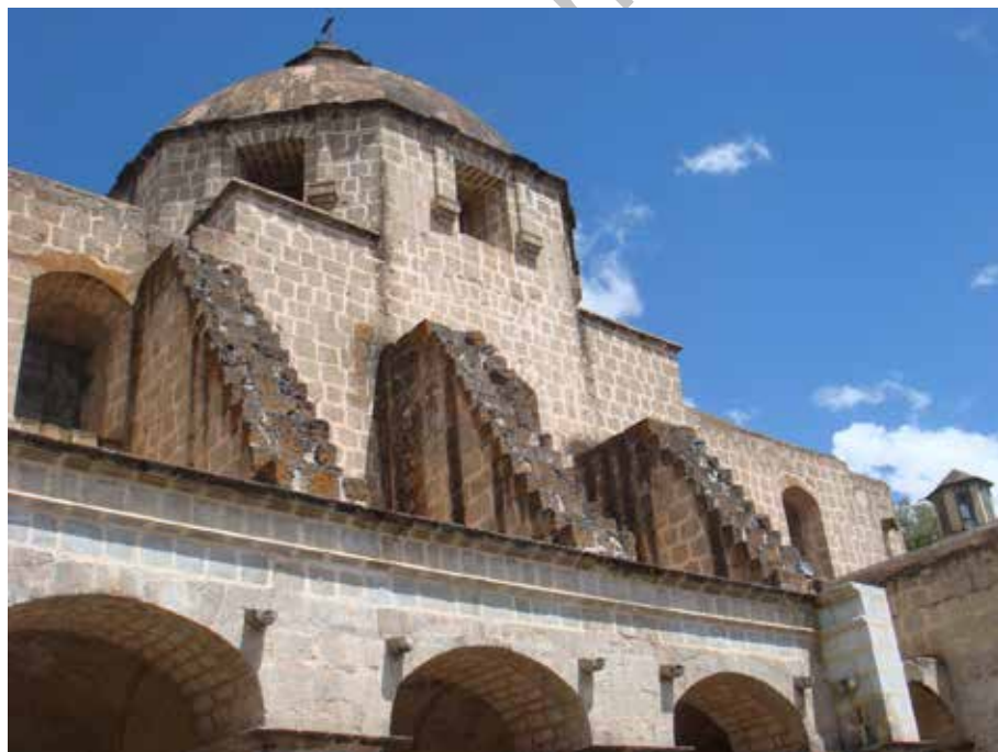
Contrafuertes de la iglesia de Belén. Vista desde el patio del hospital de varones. Fotografía de A. Scaletti (2010).
