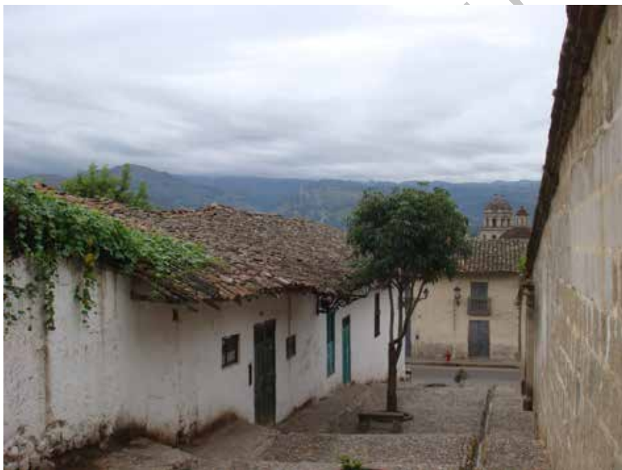
Una calle peatonal «estrecha» subiendo la ladera del cerro Cumbe desde la calle Junín. Fuente: Archivos CIAC, fotografía de A. Scaletti (2008).
