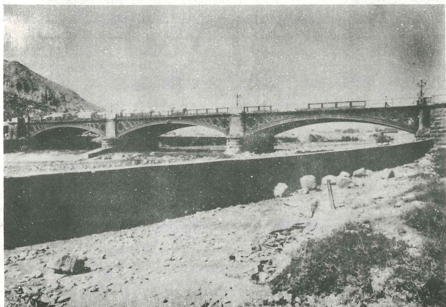
Foto 18. Lima, Puente de Balta.
