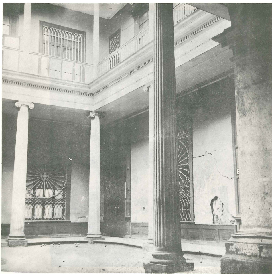
Foto 2. Lima, Casa Balta (demolida), Patio.
