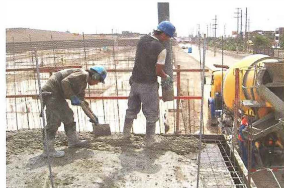
Foto 14. Vaciado con bomba Unicon
