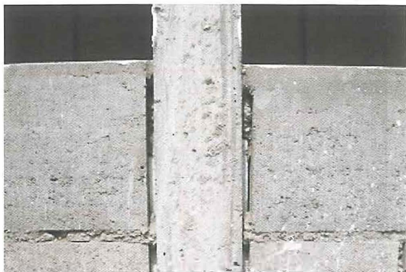
Foto 17. Separación de 1/2" con tecnoport entre MDL y Ladrillo
