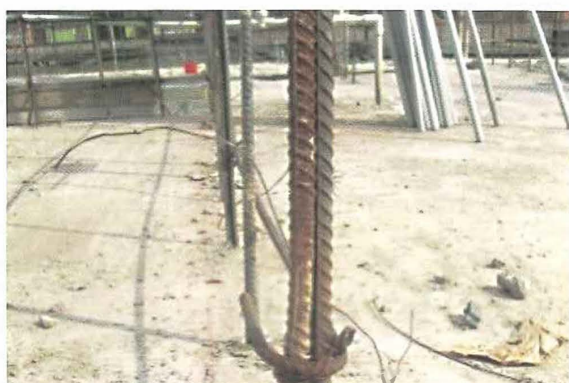
Foto 21. Grifado de acero vertical
