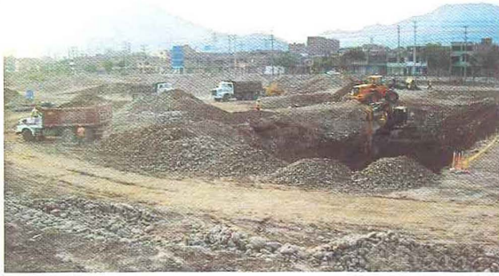
Foto 1. Corte, Zarandeo y Traslado del Relleno de Ingeniería
