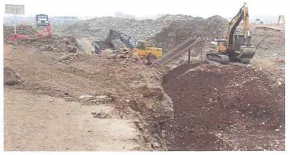
Foto 2. Corte y Zarandeo del material Granular
