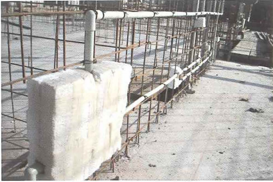
Foto 9. Llaves de agua del dpto. Colocadas antes del vaciado
