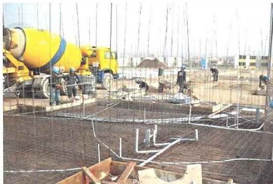
Foto 5. Vaciado de Plateas – Sector I
