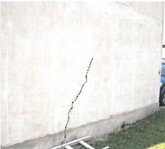
Foto 27. Fisura en la parte inferior de los MDL de 8m de longitud 8m.
