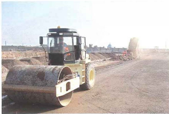
Foto 3. Compactación en capas de 30cm
