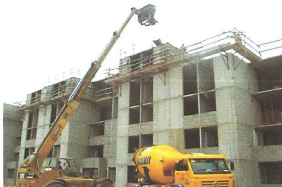
Foto 15. Vaciado con brazo Telescópico (Telehandler)
