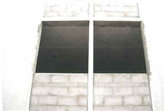
Foto 24. Reparación de derrame de ventanas
