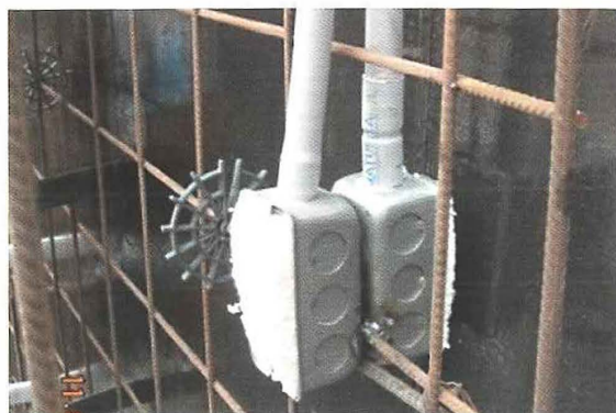
Foto 7. Caja Eléctrica sujeta a la malla electrosoldada
