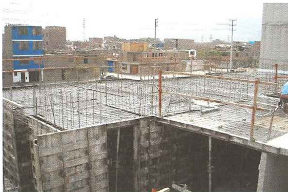
Foto 13. Encofrado Monolítico (Muros y Losas)
