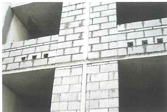
Foto 18. Fachada con Ladrillo de concreto vibrado P-9
