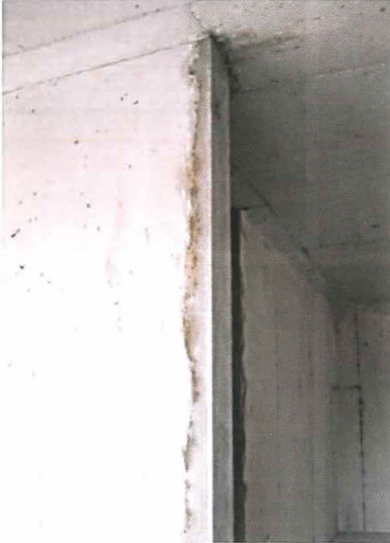
Foto 25. Reparación de derrame de puertas
