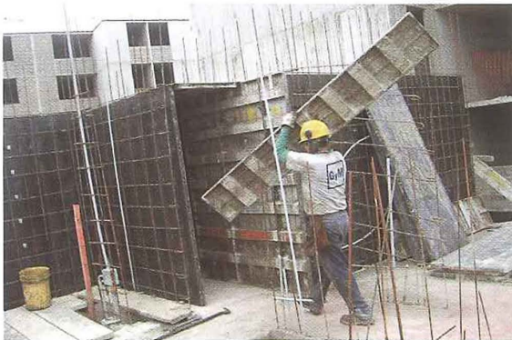
Foto 11. Traslado rápido y fácil de Formaletas de Encofrado
